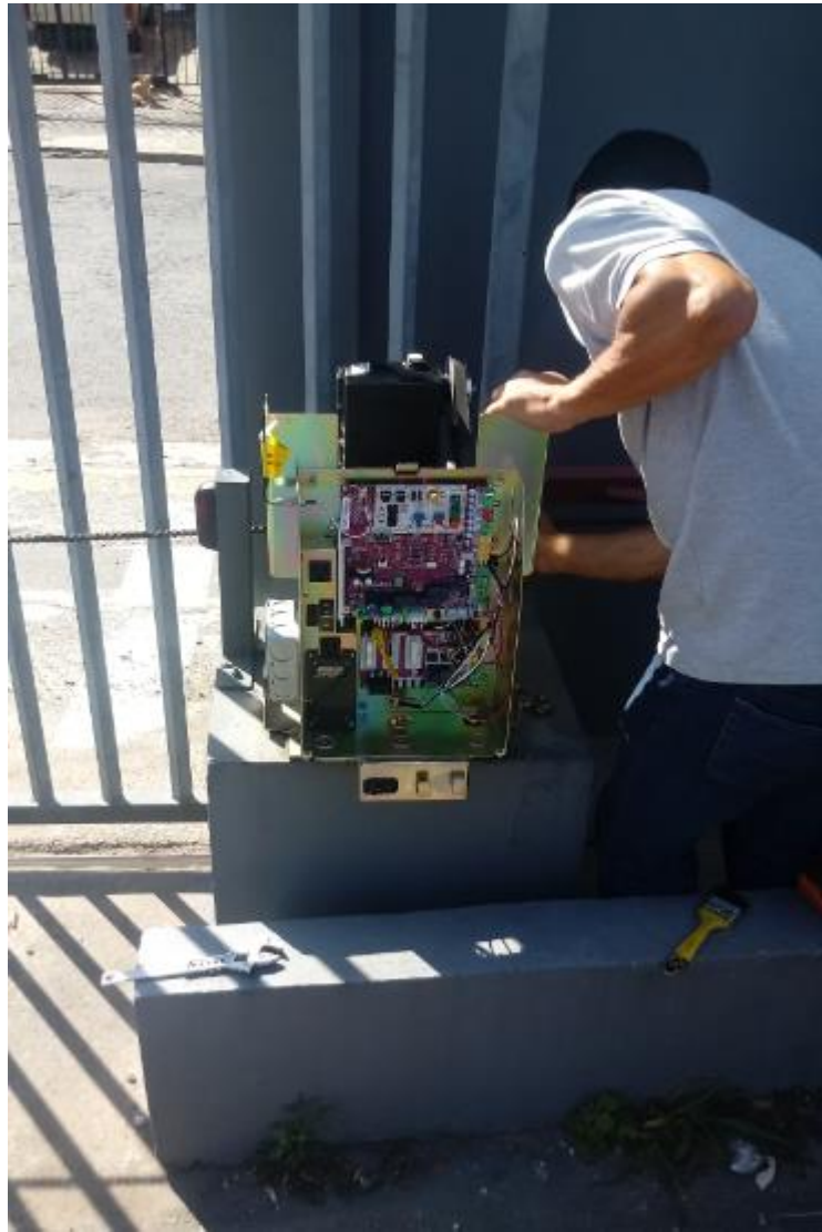
Figura 8.8 Visita de mantenimiento portones y accesos automáticos
