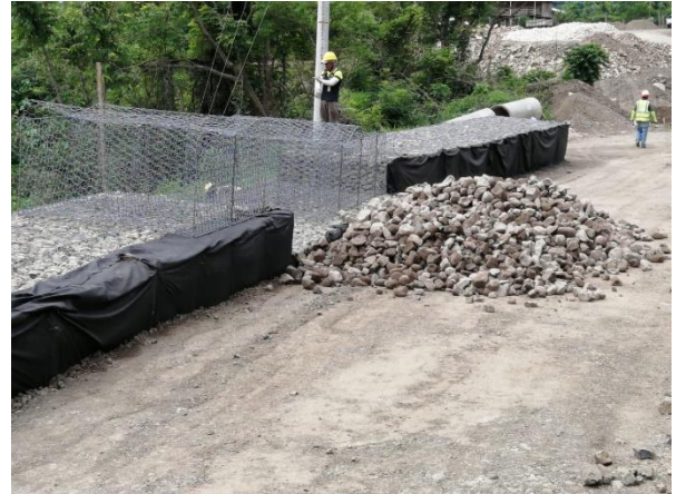
Figura 76. Ubicación de piedra gavión para llenado de tercer nivel de sección 2.
