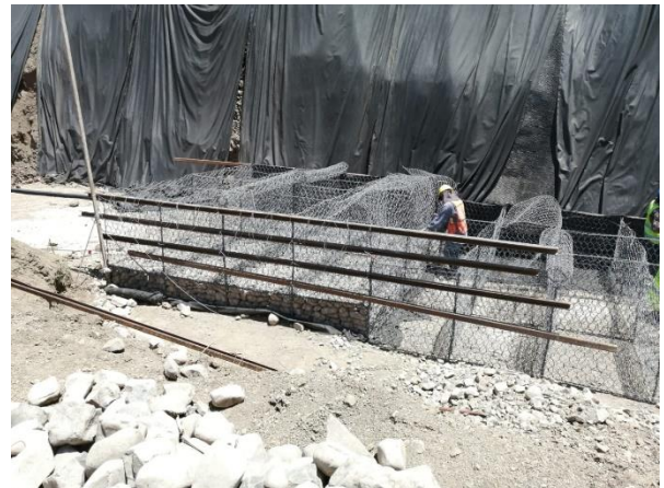
Figura 77. Ejemplo de colocación de formaleta en muro 4+200.
