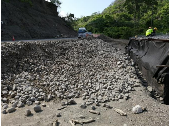
Figura 61. Colocación de la piedra cerca del muro.
