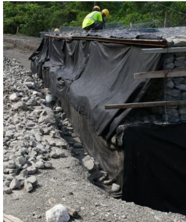
Figura 58. Geotextil colocado en tercer nivel.
