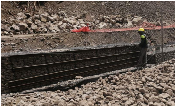
Figura 9. Formaleta colocada en cara visible del muro.
