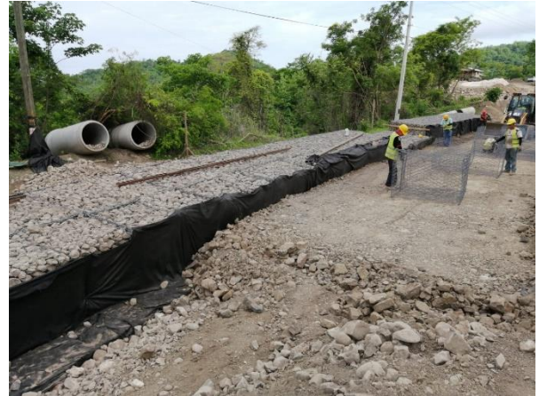
Figura 71. Armado de cajones de tercer nivel sección 2.
