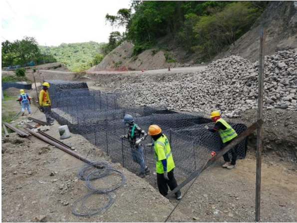
Figura 66. Colocación de cajones de primer nivel sección 3
