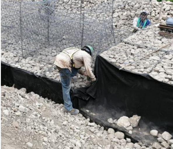
Figura 8. Amarrado de geotextil.
