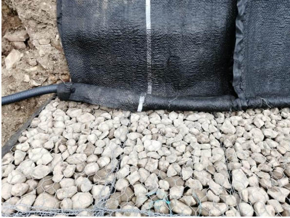
Figura 78. Ejemplo de colocación de tubería perforada.
