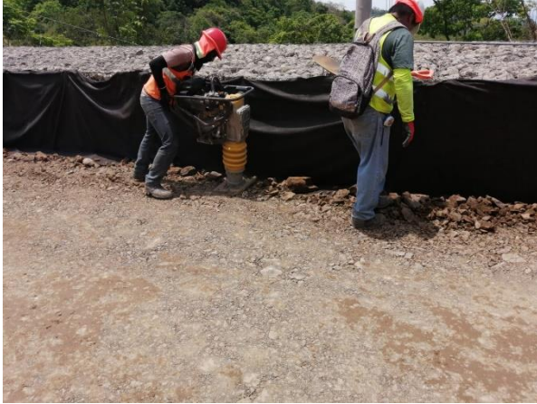
Figura 12. Compactación de franja de 1 metro que colinda con el muro.
