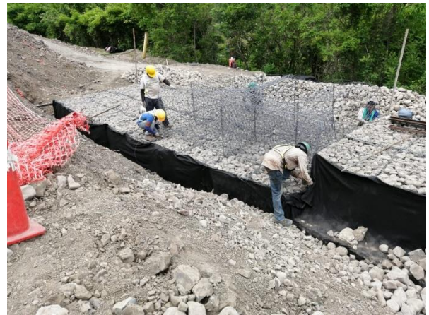
Figura 72. Colocación de cajones en segundo nivel sección 4.
