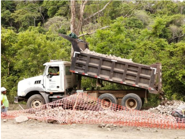
Figura 65. Descarga de piedra gavión.
