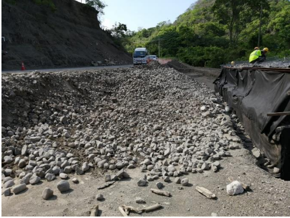
Figura 67. Ubicación de piedra gavión para llenado
