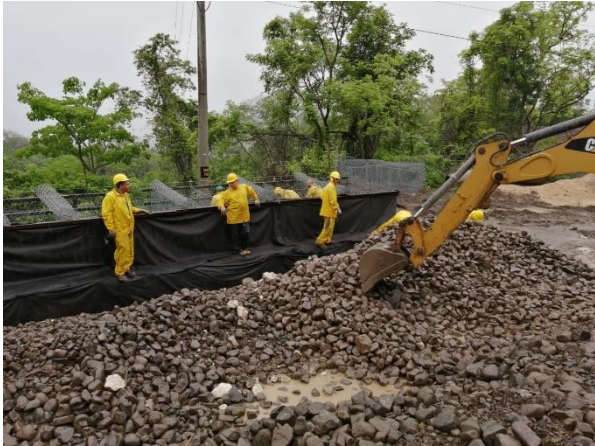
Figura 68. Revolvimiento de piedra por medio de back hoe.
