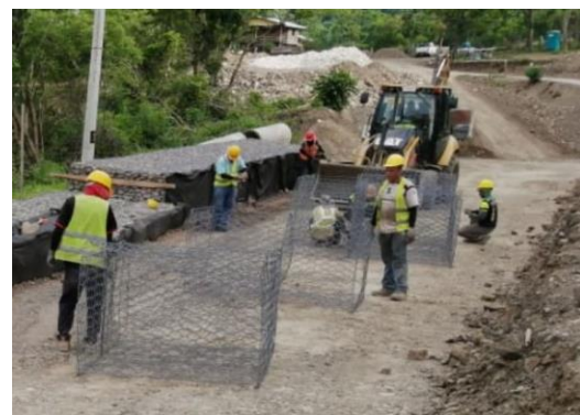
Figura 7. Armado de cajones.
