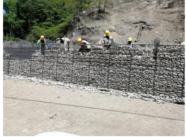
Figura 81. Llenado de tercer nivel.
