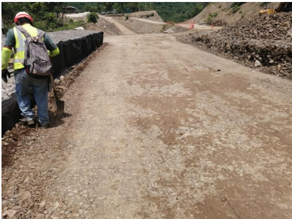
Figura 69. Acabado de compactación
