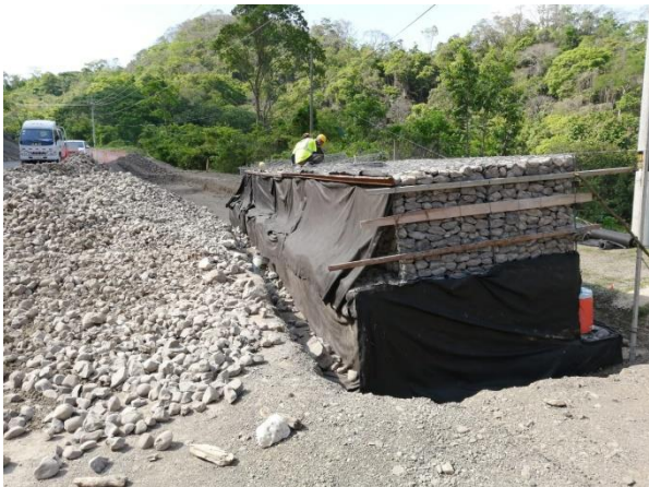
Figura 63. Costura del tercer nivel sección 4.
