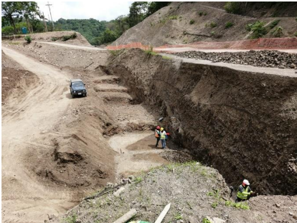
Figura 79. Ejemplo de terraseo de base de muro.
