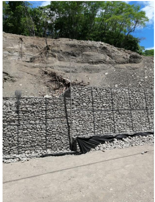
Figura 82. Acabado de cara posterior al talud (visible)
