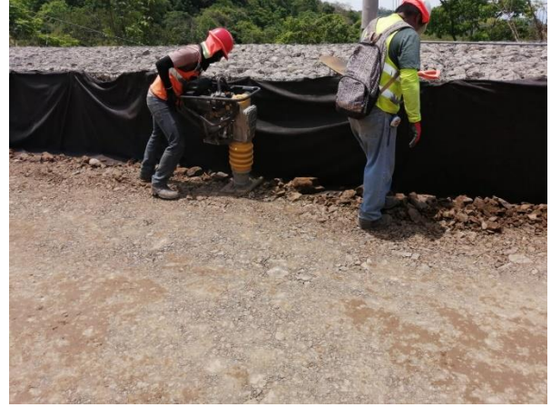
Figura 70. Compactación a orillas del gavión por medio de sapo compactador.
