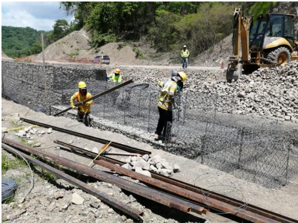
Figura 74. Formaleteo de segundo nivel sección 2.
