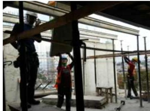
Figura 67. Encofrado de losa con sistema Convencional.
