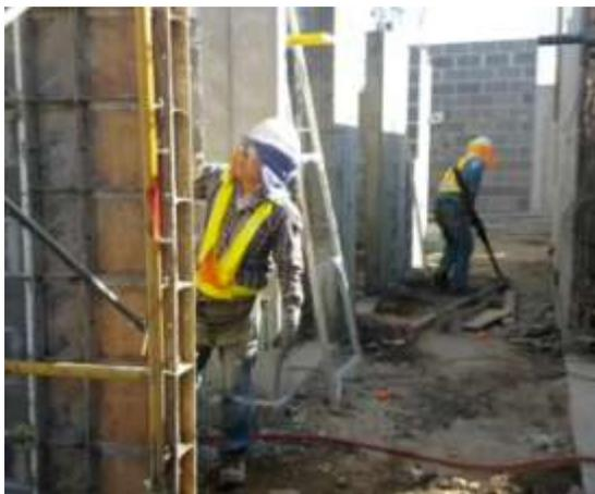
Figura 39. Desencofrado de columna con cuadrilla de dos personas.
