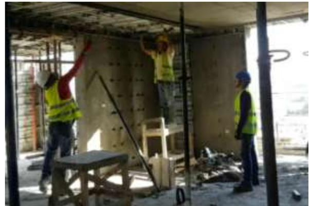
Figura 60. Desencofrado de losa con sistema Forsa.
