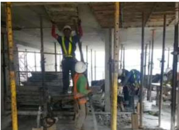
Figura 73. Desencofrado de losa con sistema Convencional.
