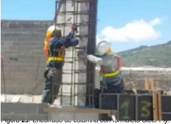
Figura 25. Encofrado de columna con formaleta Steel-Ply.
