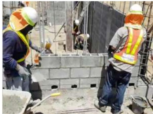
Figura 10. Colocación y sisado de bloques.
