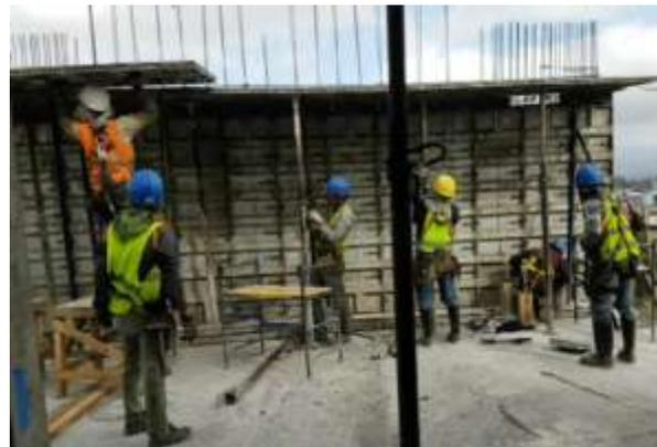
Figura 54. Encofrado de losa con sistema Forsa.
