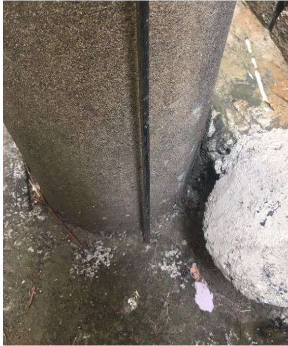
Figura 3.20 Tierra transformador acometida 1
