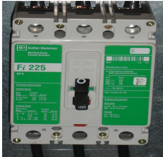
Figura 2.4 Interruptor termo-magnético
