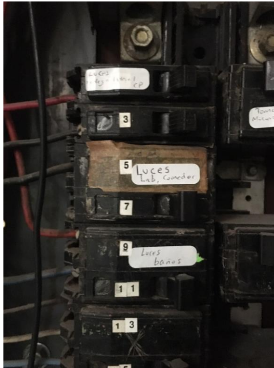
Figura 3.7 Disyuntores tablero Lab CP
