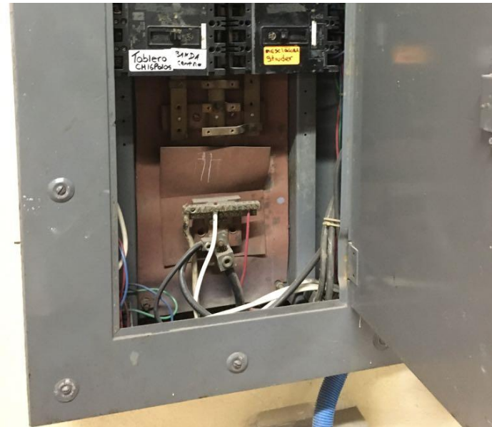
Figura 3.12 Tablero con mal código de colores Fuente: Fotografía propia
