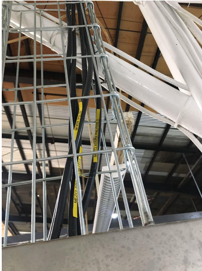
Figura 3.2 Salidas con cables TSJ
