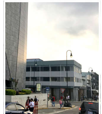
Figura 53: Vista de la esquina del lote.
