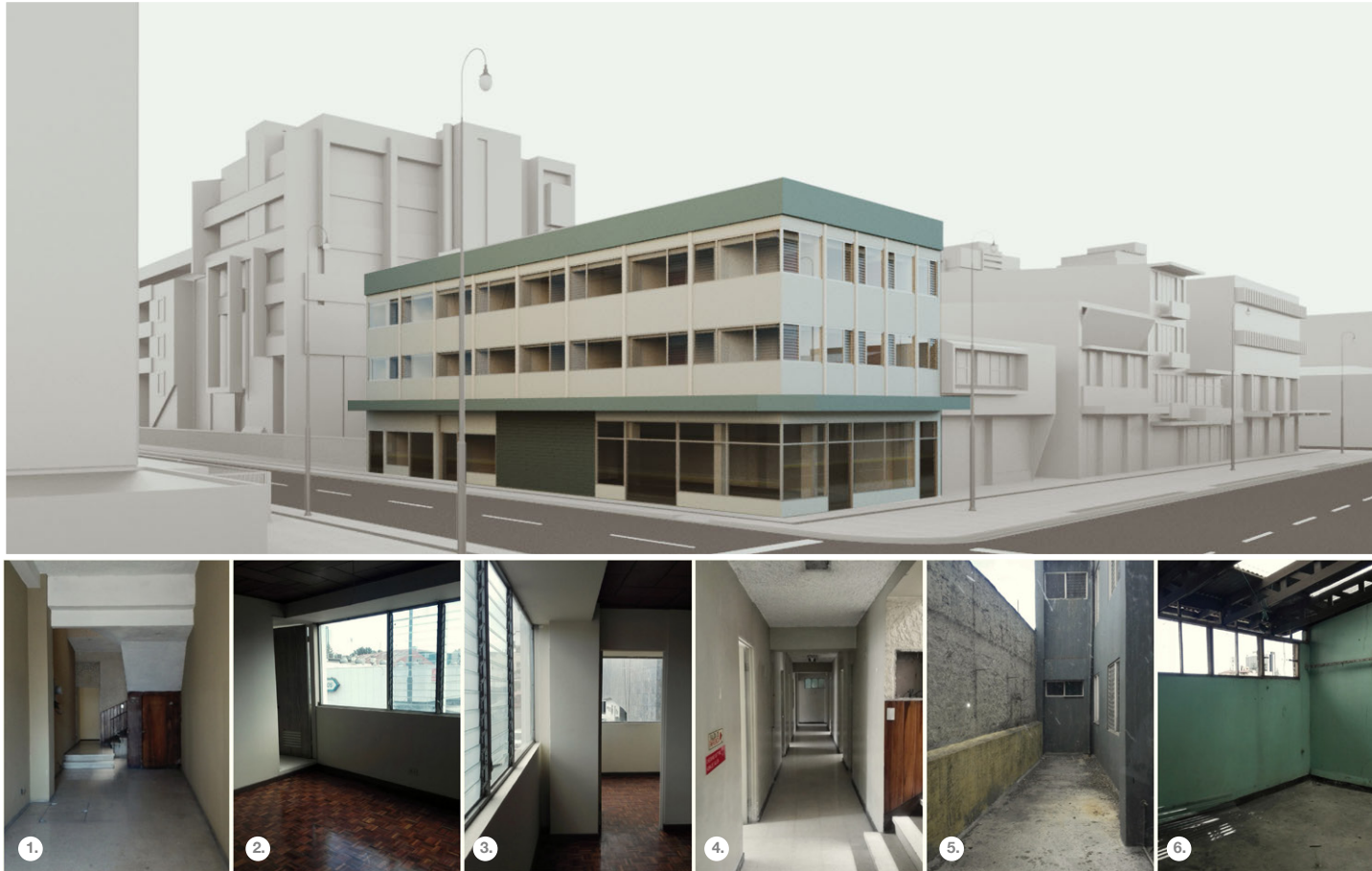
Figura 43: Edificio Galilea. 1. Entrada al edificio, 2. Habitación del edificio, 3. Habitación del edificio, 4. Pasillo, 5. Patio de luz, 6. Palomar.
