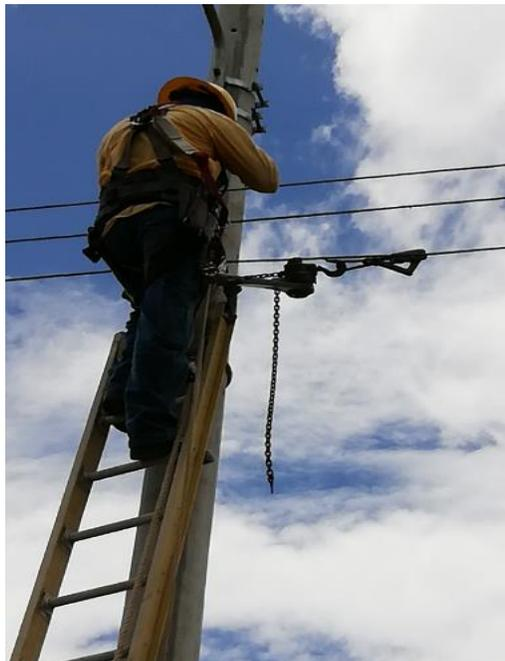
**Figura 7. “Colocación de herrajes de metal en el poste”.**
