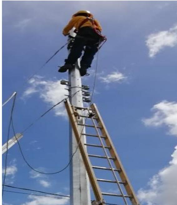
**Figura 8. “Tensado de retenidas y cableado.”**
