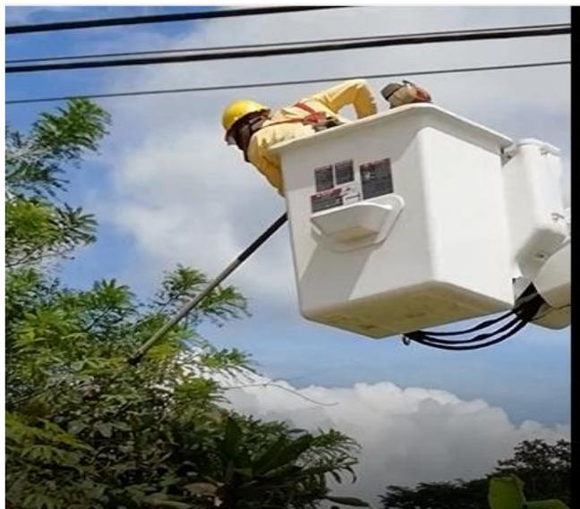
**Figura 11. “Descuaje utilizando sierra telescópica sobre la canasta”.**
