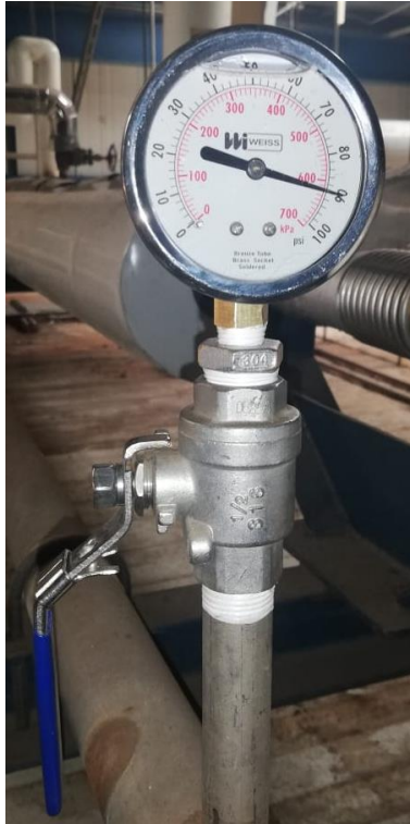
Figura 33 Método de Medición de la caída de Presión en la línea de Sardina y Harinera
