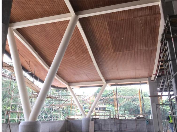
**Figura 85.** Colocación de cielo raso, módulo A, nivel 917. Fuente: Tomada en sitio
