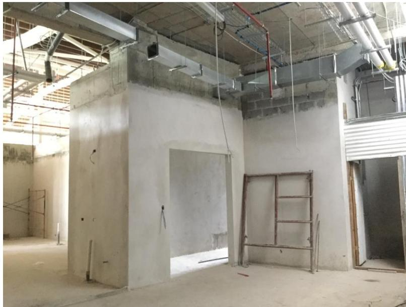
**Figura 88.** Paredes resanadas, módulo B, nivel 917. Fuente: Tomada en sitio
