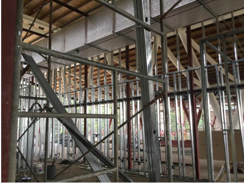
**Figura 89.** Paredes livianas y sistema aire acondicionado en sport bar, módulo B, nivel 922. Fuente: Tomada en sitio
