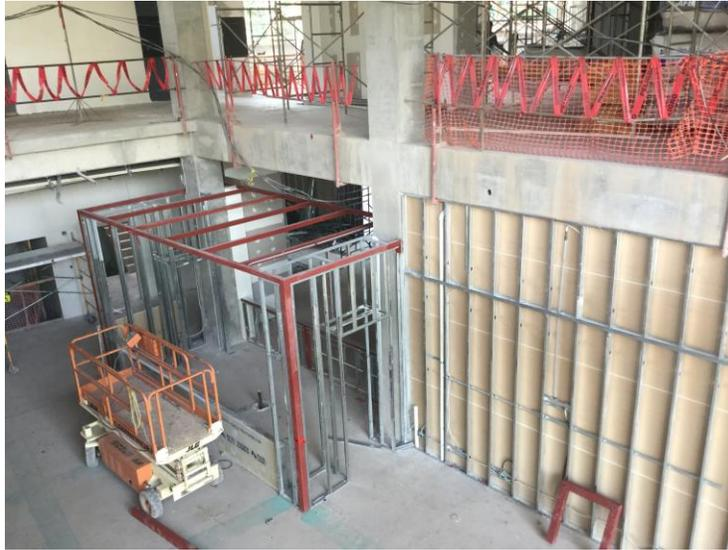
**Figura 83.** Paredes livianas, módulo A, nivel 912. Fuente: Tomada en sitio
