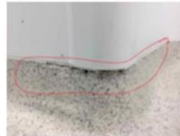
Figura 23. Ítem de la lista de poncheo del proceso de colocación de acabado epóxico de los cuartos limpios
