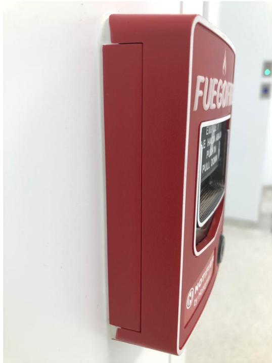
Figura 42. Colocación de silicón alrededor de las estaciones manuales de los cuartos limpios.
