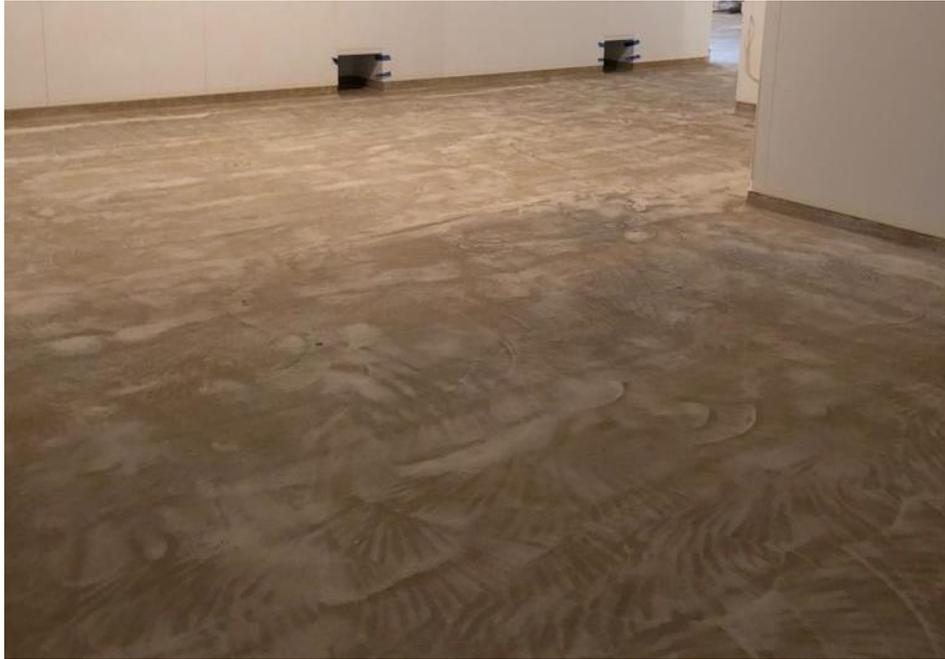
Figura 36. Mortero de los cuartos limpios después del proceso de pulido.
