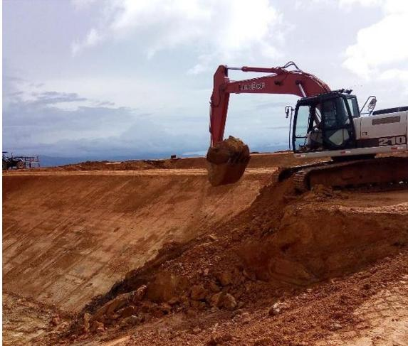
Figura 42. Conformación de taludes.
