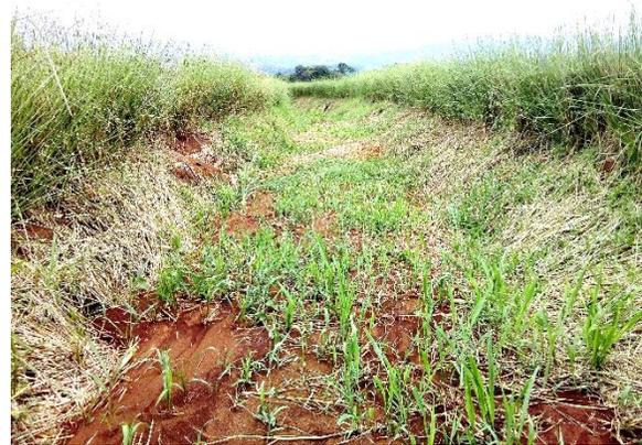
Figura 47. Canal con alta cantidad de sedimentos.
