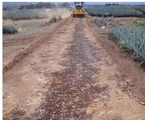
Figura 36. Raspado de calzada.
