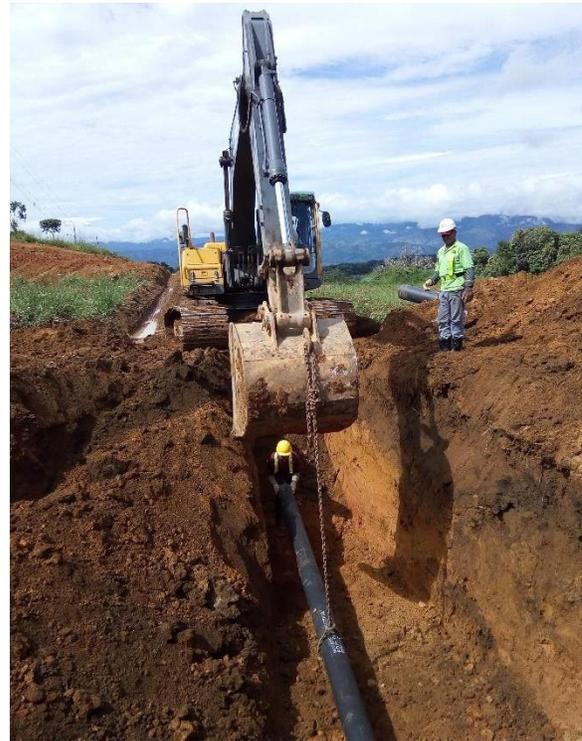
Figura 41. Colocación de tubería.
