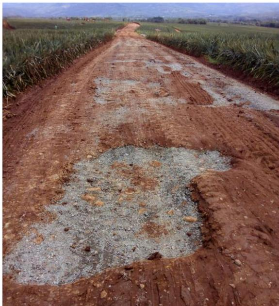
Figura 37. Calzada deteriorada con barro sólido.
