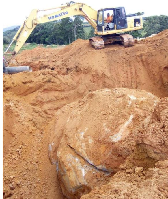
Figura 62. Imprevisto del terreno, aparición de piedra.
