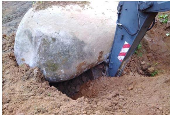
Figura 58. Accidente de piedra sobre balde de la excavadora.
