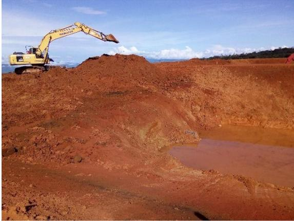
Figura 64. Trabajos con alto nivel freático.
