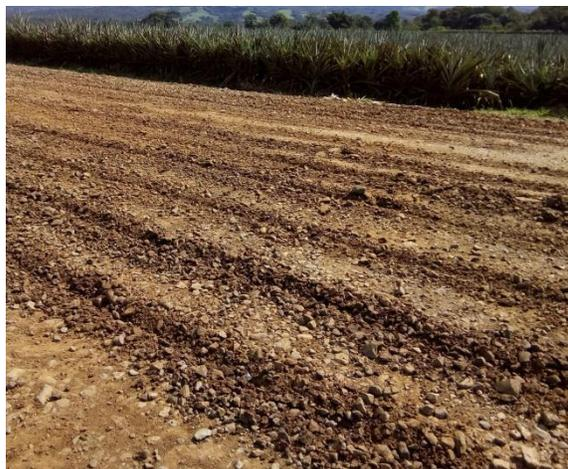
Figura 38. Calzada en proceso de ripiado.
