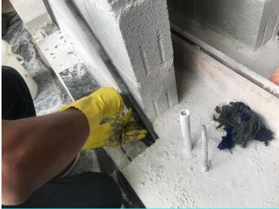
Figura 62. Colocación de las platinas sobre bandas de fibra
