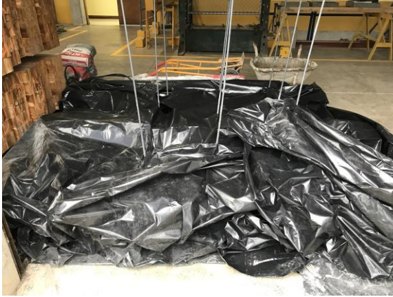
Figura 31. Cubierta de fundaciones para evitar contracción del concreto
