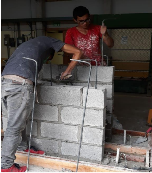
Figura 34. Proceso de envarillado del concreto de relleno de celdas
