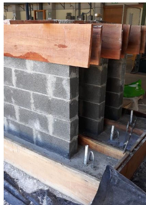
Figura 40. Finalización de construcción muestras
