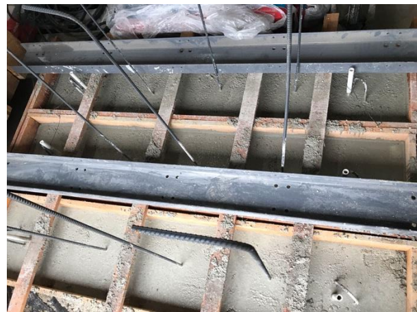
Figura 30. Finalizado de colado de fundaciones
