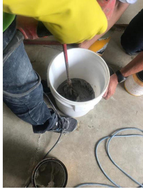
Figura 55. Preparación y mezclado de componentes A y B de las resinas epóxicas
