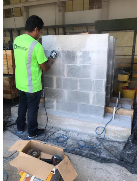
Figura 51. Preparación de superficie de muros
