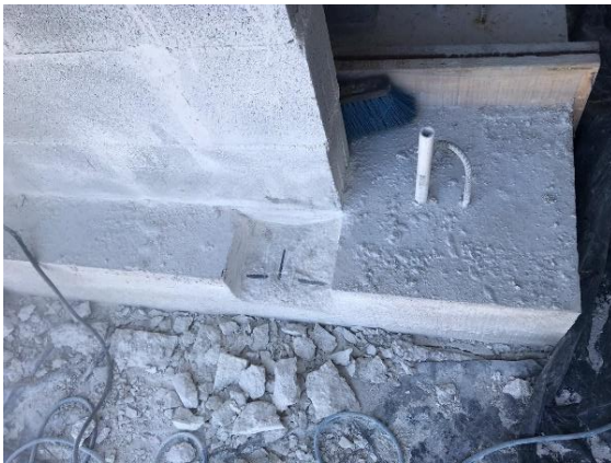
Figura 54. Corte en cimentación para anclaje
