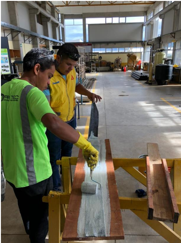
Figura 57. Aplicación de sikadur 301 a SikaWrap
