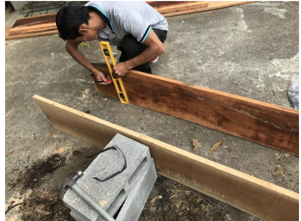
Figura 25. Armado de formaleta para placas de cimentación
