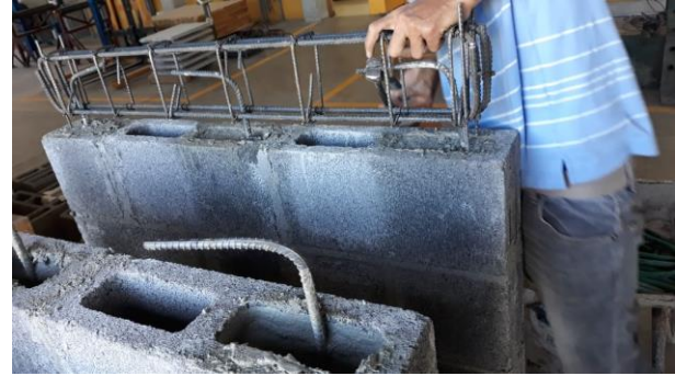
Figura36. Colocación de armadura de viga corona
