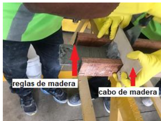
Figura 56. Aplicación de sikadur -30 a SikaCarbodur
