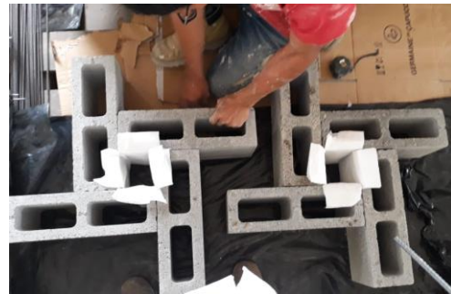
Figura 94. Elaboración de muestras (prismas) de concreto de relleno
