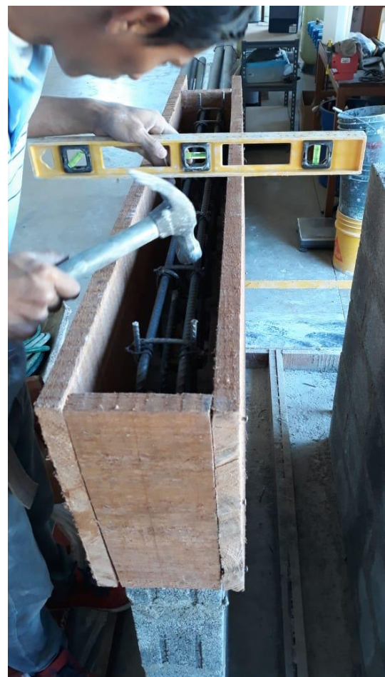
Figura37. Colocación de formaleta para viga corona
