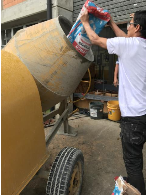
Figura 27. Elaboración de concreto para fundaciones
