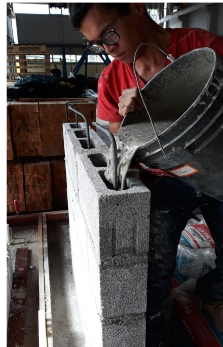
Figura 33. Relleno de celdas con concreto
