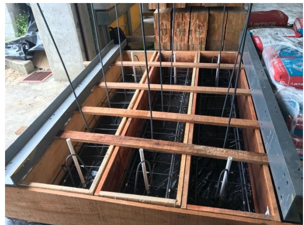
Figura 26. Formaletas y acero de refuerzo colocado
