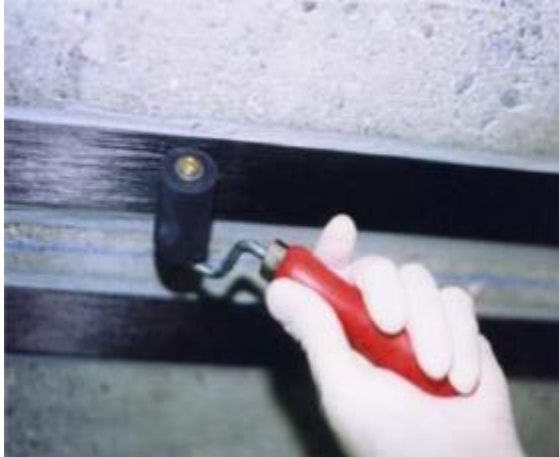
Figura 59. Proceso de colocación de las bandas SikaCarbodur S1012 sobre el muro
