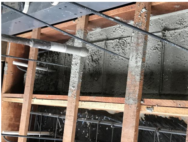
Figura 28. Colado y vibrado de concreto en fundaciones
