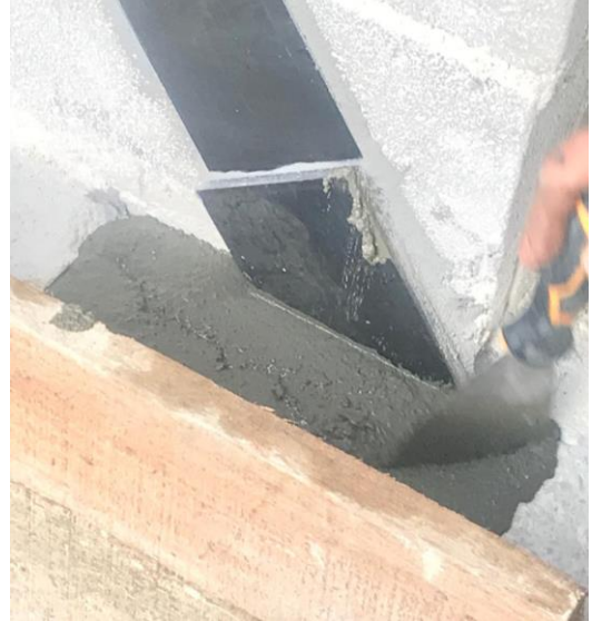
Figura 64. Colocación de mortero SikaGrout en anclajes
