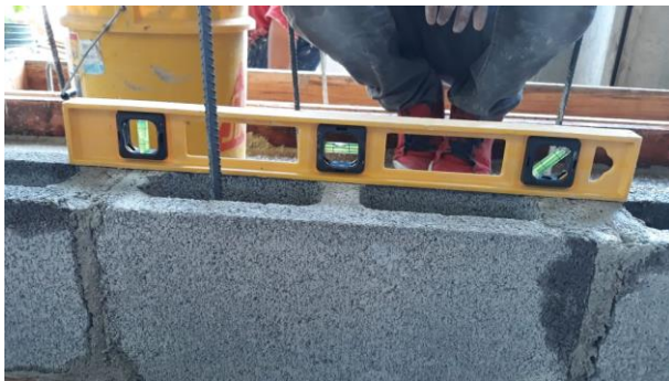
Figura 35. Verificación de nivel de las hiladas de bloques
