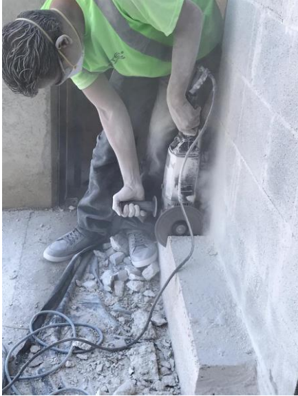
Figura 53. Corte en cimentación para introducción de la platina metálica
