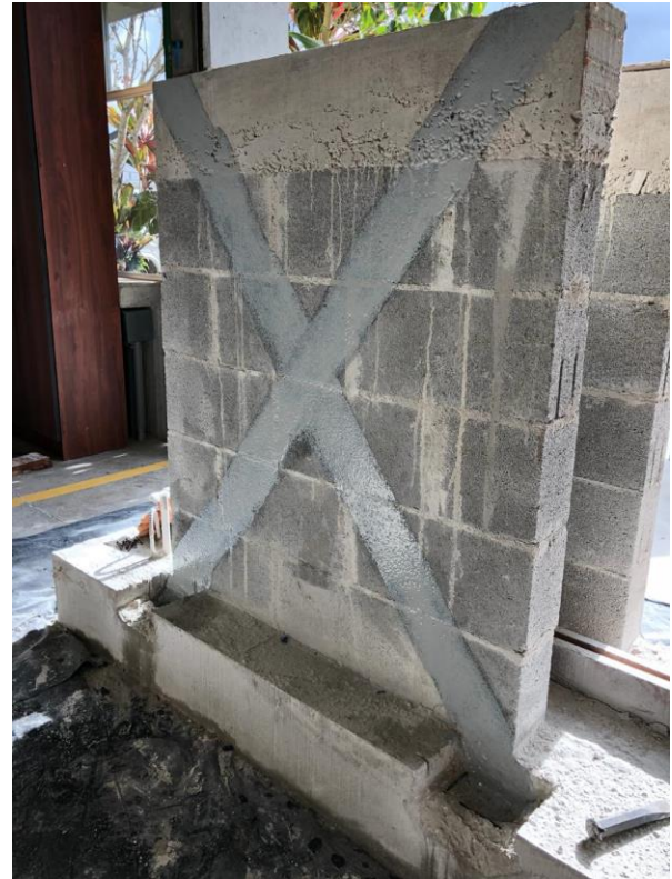
Figura 58. Colocación de adhesivo en el paño de mampostería
