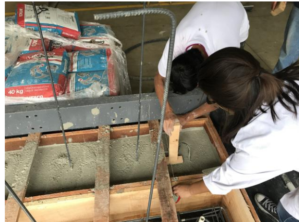
Figura 29. Nivelado de concreto en fundaciones
