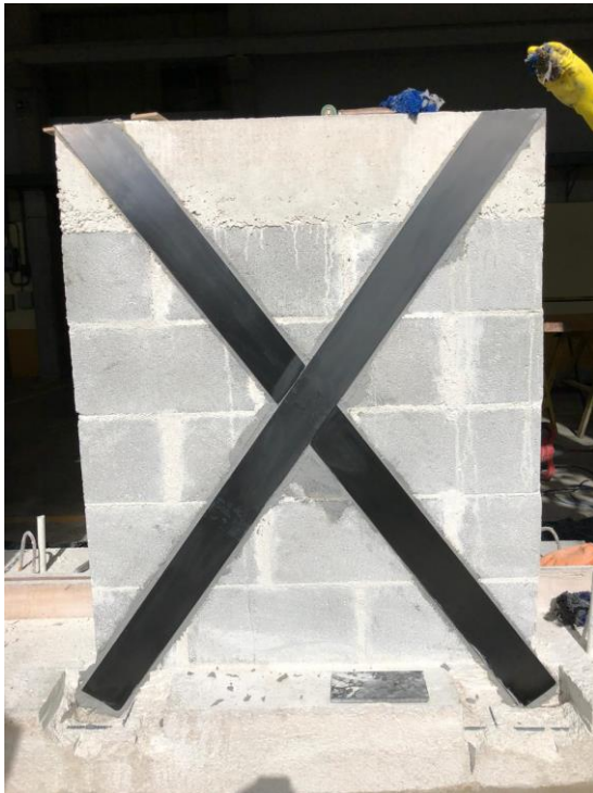
Figura 60. Colocación de las bandas SikaCarbodur S1012 sobre el muro
