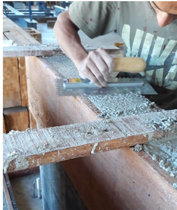
Figura 39. Proceso de nivelación y acabado de concreto en viga corona
