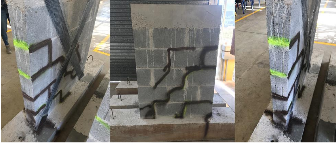
Figura 86. Falla de muestra Muro 3.
