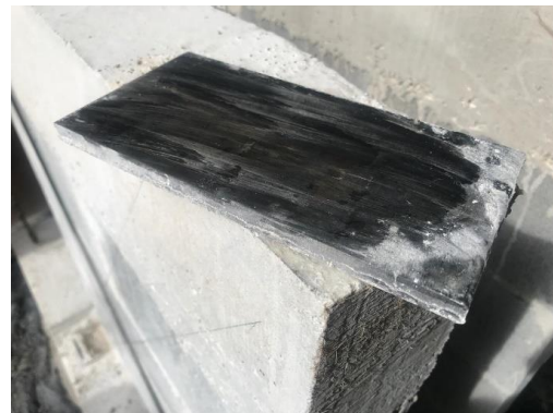
Figura 52. Platina metálica para anclaje de fibra.
