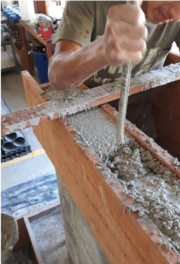
Figura 38. Proceso de envarillado de concreto en viga corona
