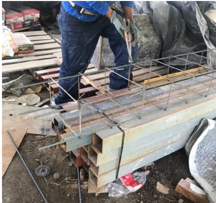
Figura 23. Amarre de aros para armaduras
