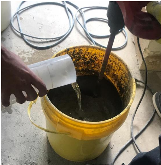
Figura 63. Preparación de mortero SikaGrout
