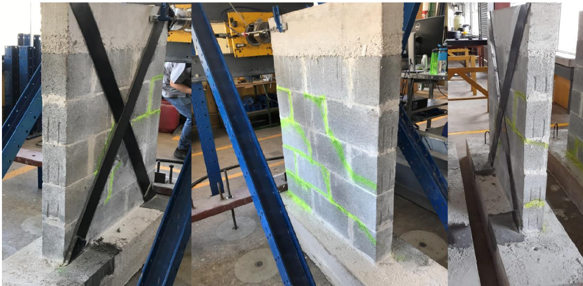
Figura 85. Falla de muestra Muro 2.
