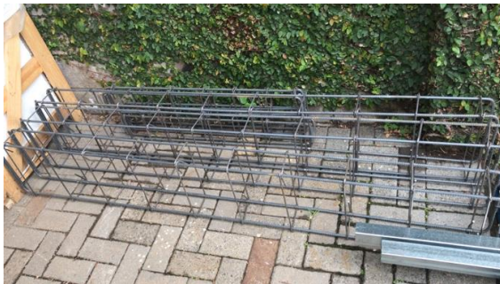
Figura 24. Armaduras de placas de cimentación y vigas coronas
