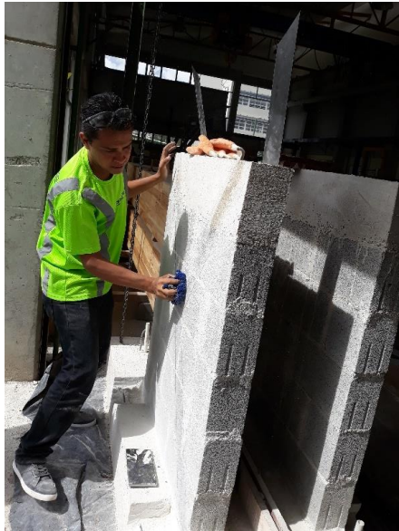
Figura 50. Preparación de superficie de muros
