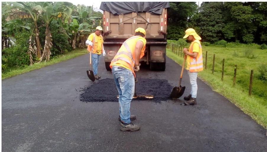
**Figura 8.** Bacheo, colocación de mezcla asfáltica.
