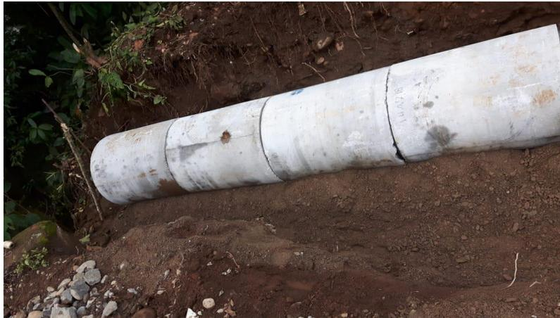
**Figura 16.** Tubería de concreto para evacuación pluvial colocada.
