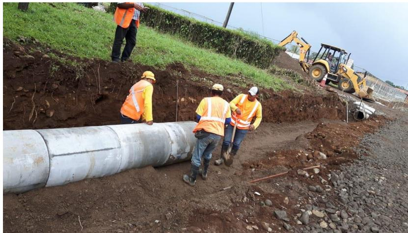
**Figura 15.** Colocación de tubería de concreto para evacuación pluvial.
