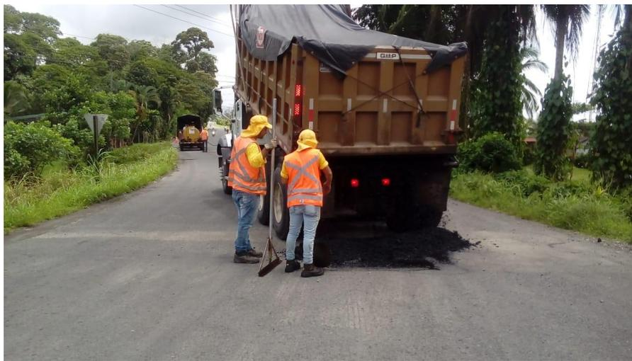
**Figura 7.** Bacheo, descarga de mezcla asfáltica.
