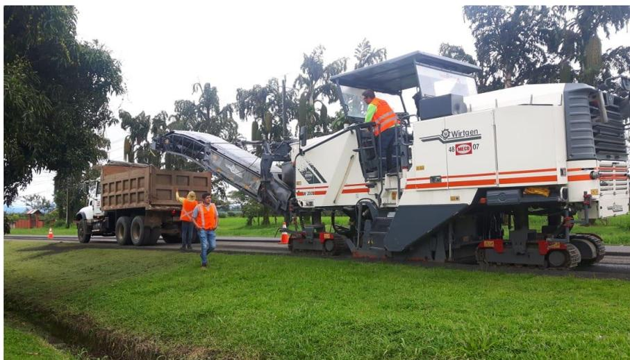
**Figura 10.** Bacheo a profundidad parcial, Perfilado de carpeta asfáltica.
