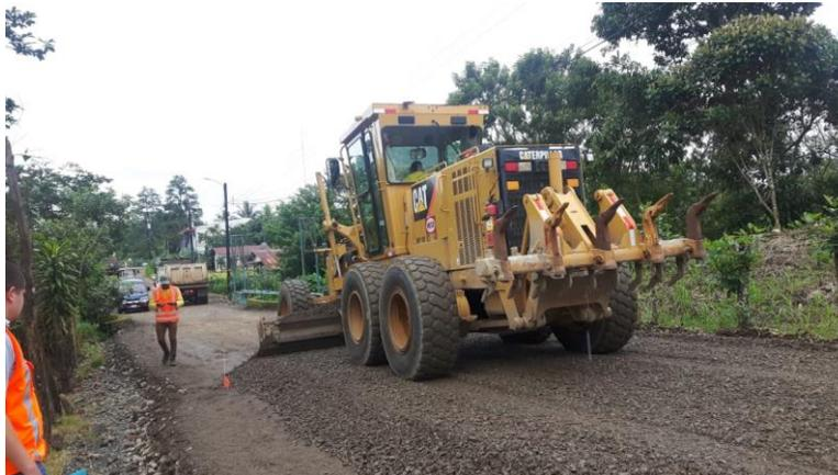
**Figura 12.** Colocación y tendido de base granular.
