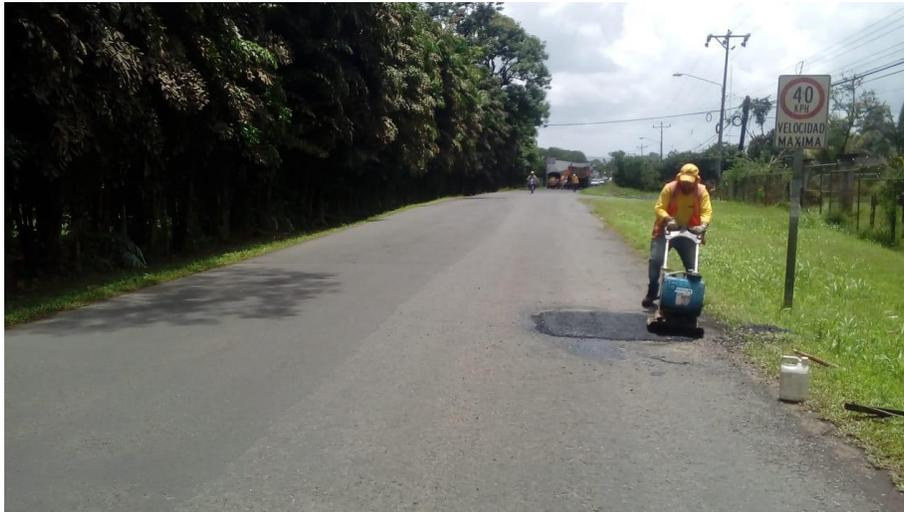
**Figura 9.** Bacheo, Compactación de la mezcla asfáltica.
