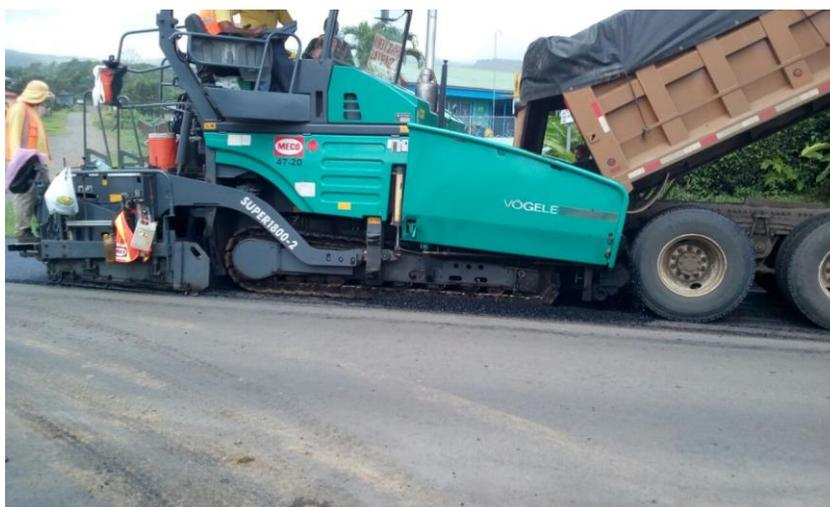
**Figura 22.** Descarga de mezcla asfáltica en pavimentadora (Finisher) y colocación de carpeta asfáltica.
