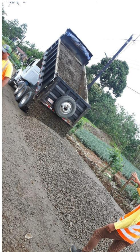
**Figura 11.** Descarga de base granular.
