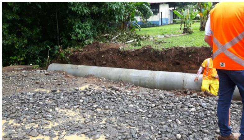
**Figura 17.** Impermeabilización de las juntas de tubería de concreto para evacuación pluvial (Solaqueo).
