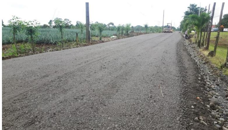
**Figura 14.** Base granular lista, faltando únicamente conformación para colocación de carpeta asfáltica.
