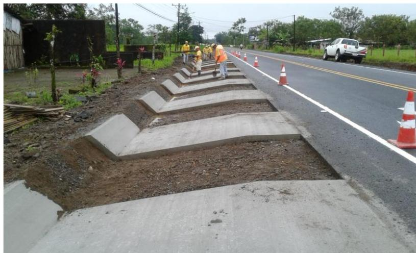
**Figura 19.** Construcción de cunetas (Canal Revestido Tipo IV) en la Ruta 751 Los Chiles Aguas Zarcas – Vuelta Kopper.
