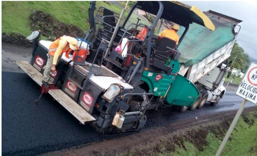
**Figura 21.** Colocación de carpeta asfáltica.
