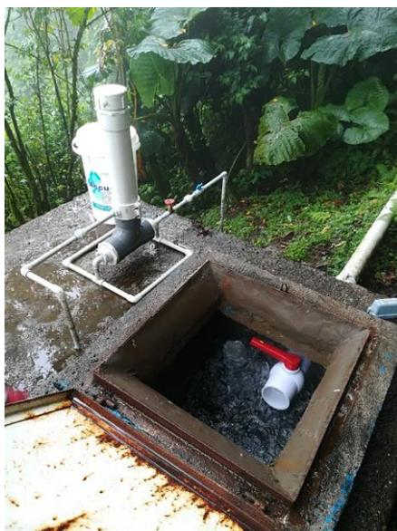
**Figura 5.11. Sistema de cloración en tanque de reunión de aguas**
