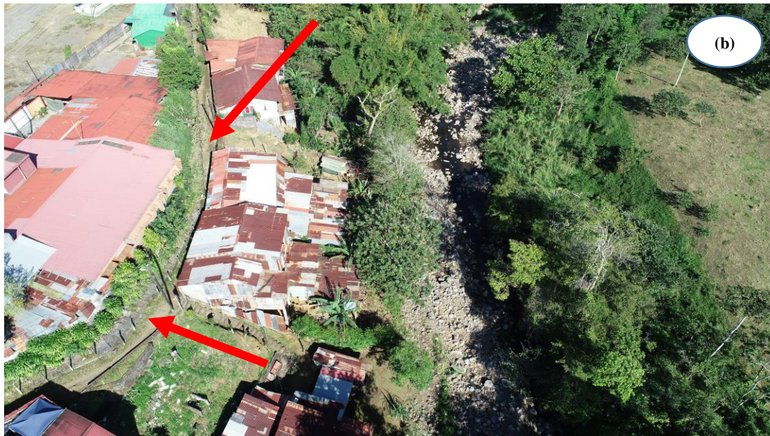
Figura 0.6. Asentamientos informales colindantes con el cauce del Río Platanar, diciembre del 2018 (a) vista desde el canal; (b) vista aérea.
