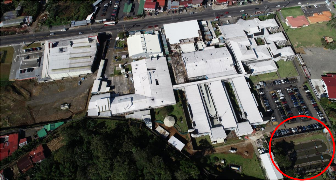
Figura 0.7. Foto aérea de Hospital de San Carlos tomada en diciembre del 2018 (PTAR en círculo rojo).
