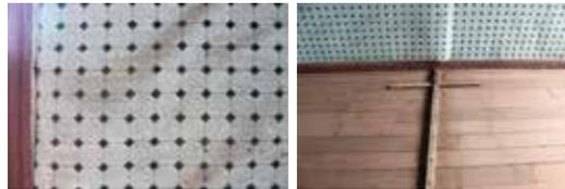
Sistemas Constructivos: Ballroom frame, entepisos de tabloncillo con cadenillos de madera sin losa de concreto y bahereque francés
