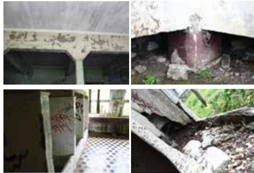
Observaciones: Baños en mal estado y conexiones con gimnasio en mal estado. Una de las conexiones no existe, piso (mosaicos) levantado en el área de comedores. El piso del segundo nivel son de tablas de madera. Los bajantes se encuentran en mal estado. El edificio cuenta con cubiertas de hierro galvanizado y se encuentran oxidadas
