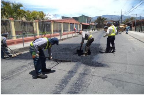
Figura 18. Distribución de mezcla asfáltica en bacheo superficial o menor.
