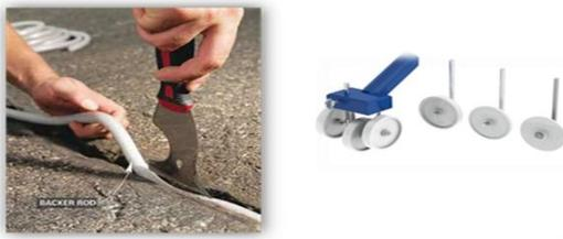
Figura 23. Sellado de fisuras en concreto hidráulico.
