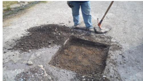
Figura 17. Corte y remoción del área afectada para bacheo formal.
