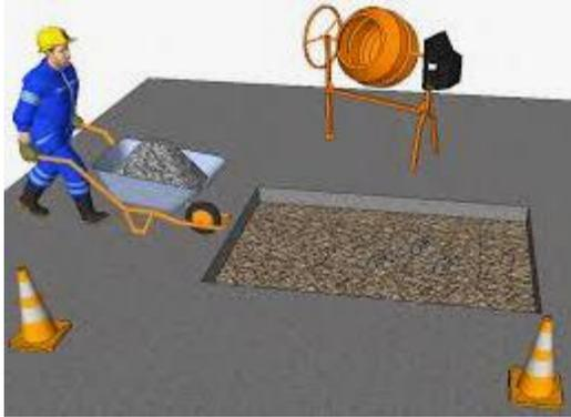
Figura 22. Bacheo con concreto hidráulico
