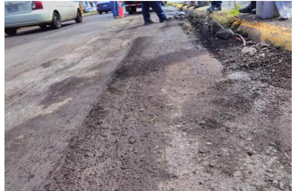
Figura 20. Sección perfilada
