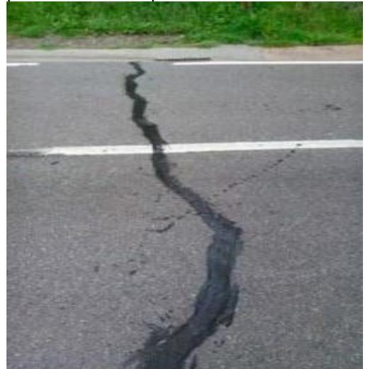
Figura 21. Sellado de fisura y grietas
