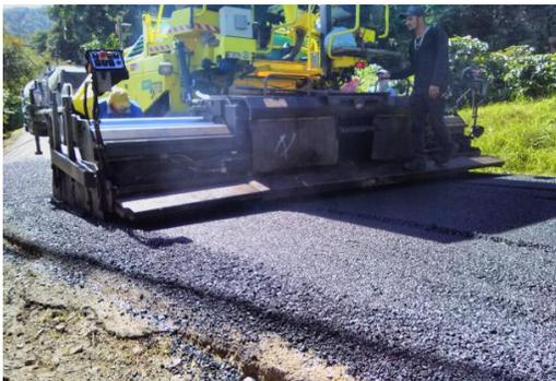
Figura 19. Colocación de sobre-capa de mezcla asfáltica.
