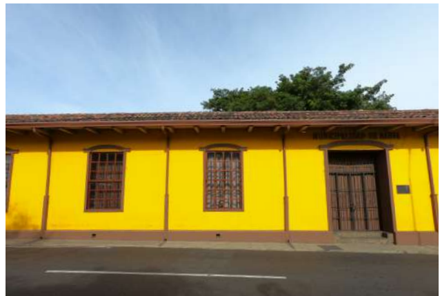
Imagen C2.45. Fachada del edificio municipal. Fuente: propia.
