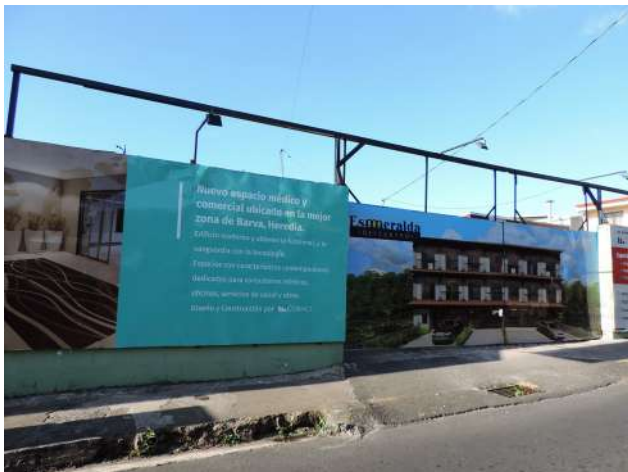
Imagen C2.32 Demolición de vivienda para nueva construcción comercial. Fuente: propia
