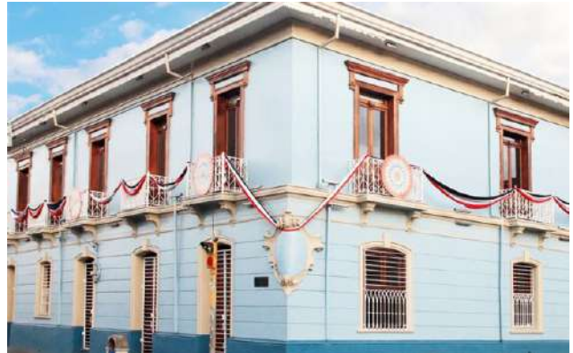
Imagen c1: Edificio Pirie. Fuente: Sitio web del TEC
