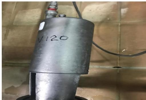
*Figura 3.19* Válvula neumática sanitaria V114.
