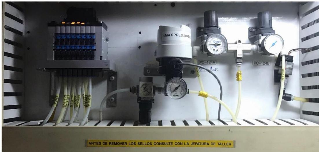
Figura 3.27 Módulos y reguladores neumáticos de la P3.
