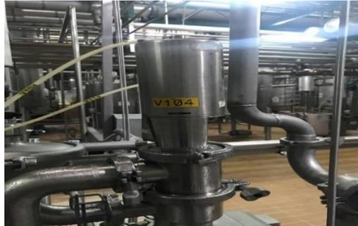
*Figura 3.17* Válvula neumática sanitaria V104.
