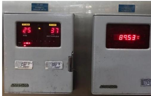
*Figura 3.38* Paneles de transmisión de temperatura y presión de la P3.
