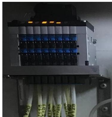
*Figura 3.45 Armario de válvulas de solenoides de la P3.*
