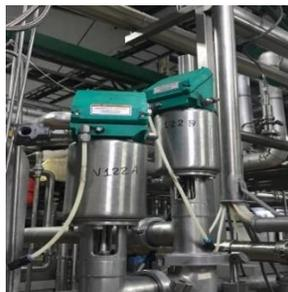
*Figura 3.21* Válvulas de desviación de flujo de la P3.
