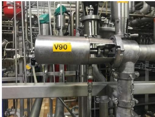
*Figura 3.18* Válvula neumática sanitaria V90.
