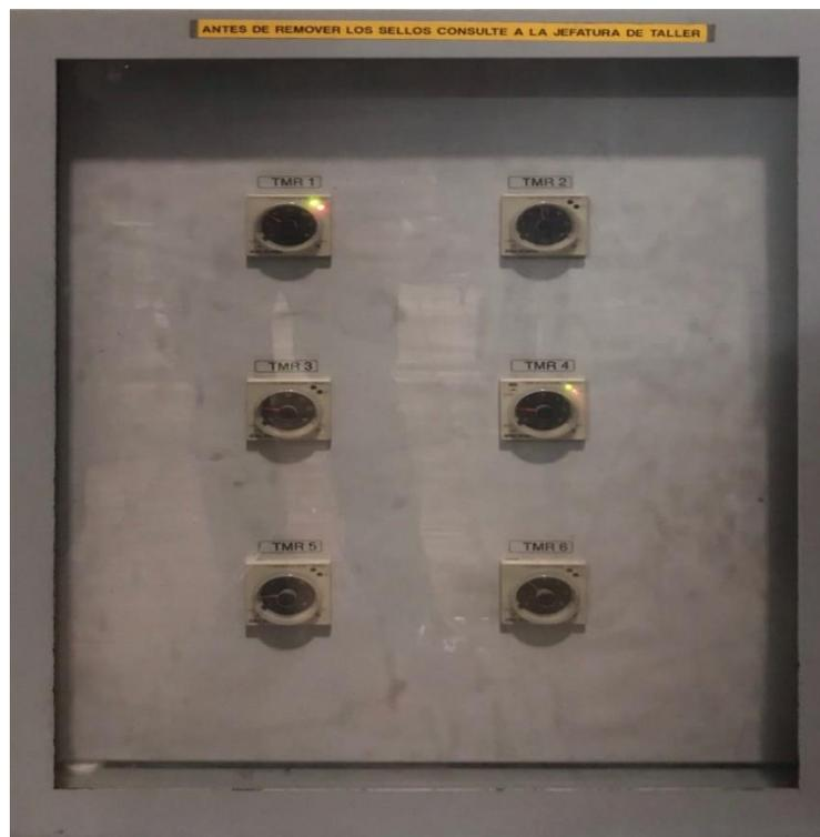
*Figura 3.26* Caja Legal del sistema de control de la P3.
