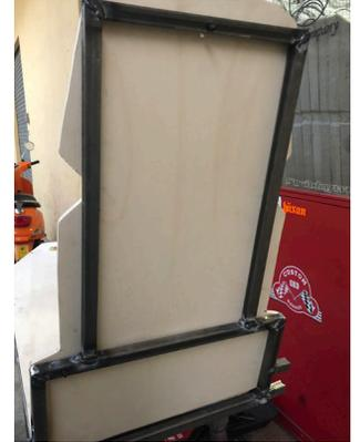
Asimismo, se debe realizar un soporte de refuerzo que una el poliestireno (corcho) con la estructura de acero.
