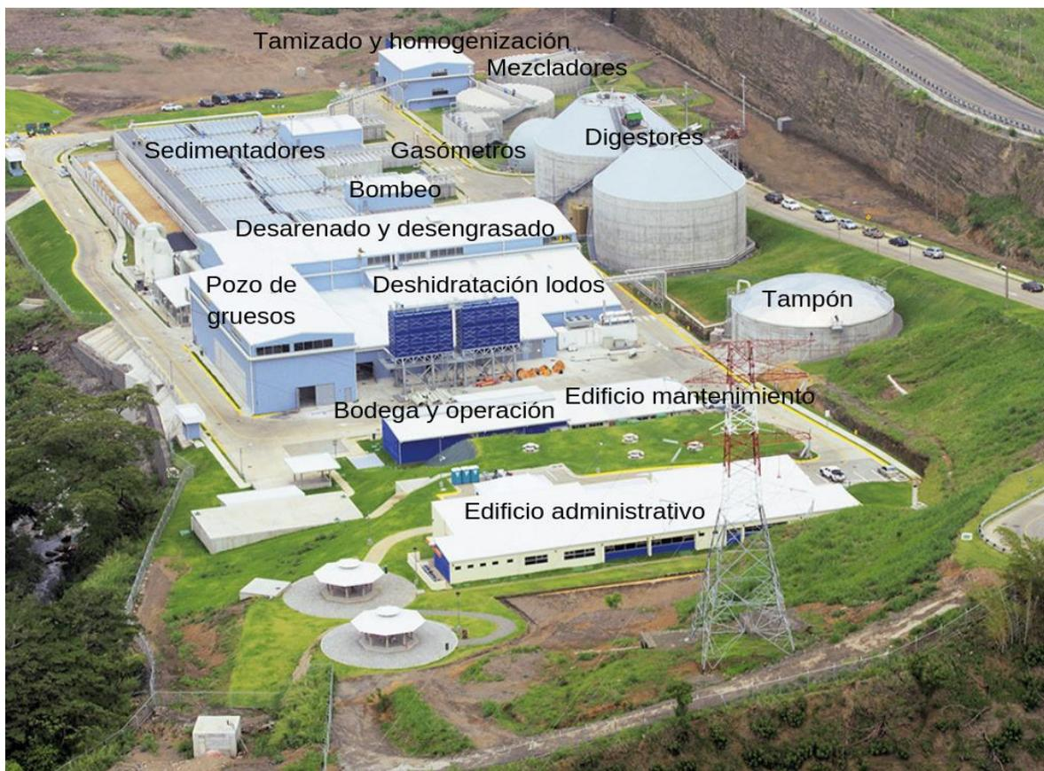
*Figura 4.2 Distribución de PTAR Los Tajos. Fuente: (PTAR Los Tajos, 2016).*
