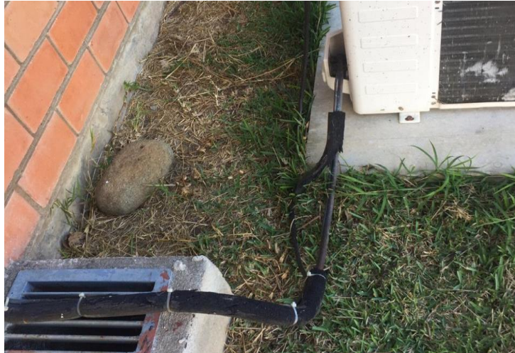
Figura 4.12 Aislamiento deteriorado.
