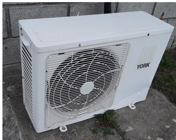
Figura 4.10 Unidad condensadora sin amortiguador cinemático.
