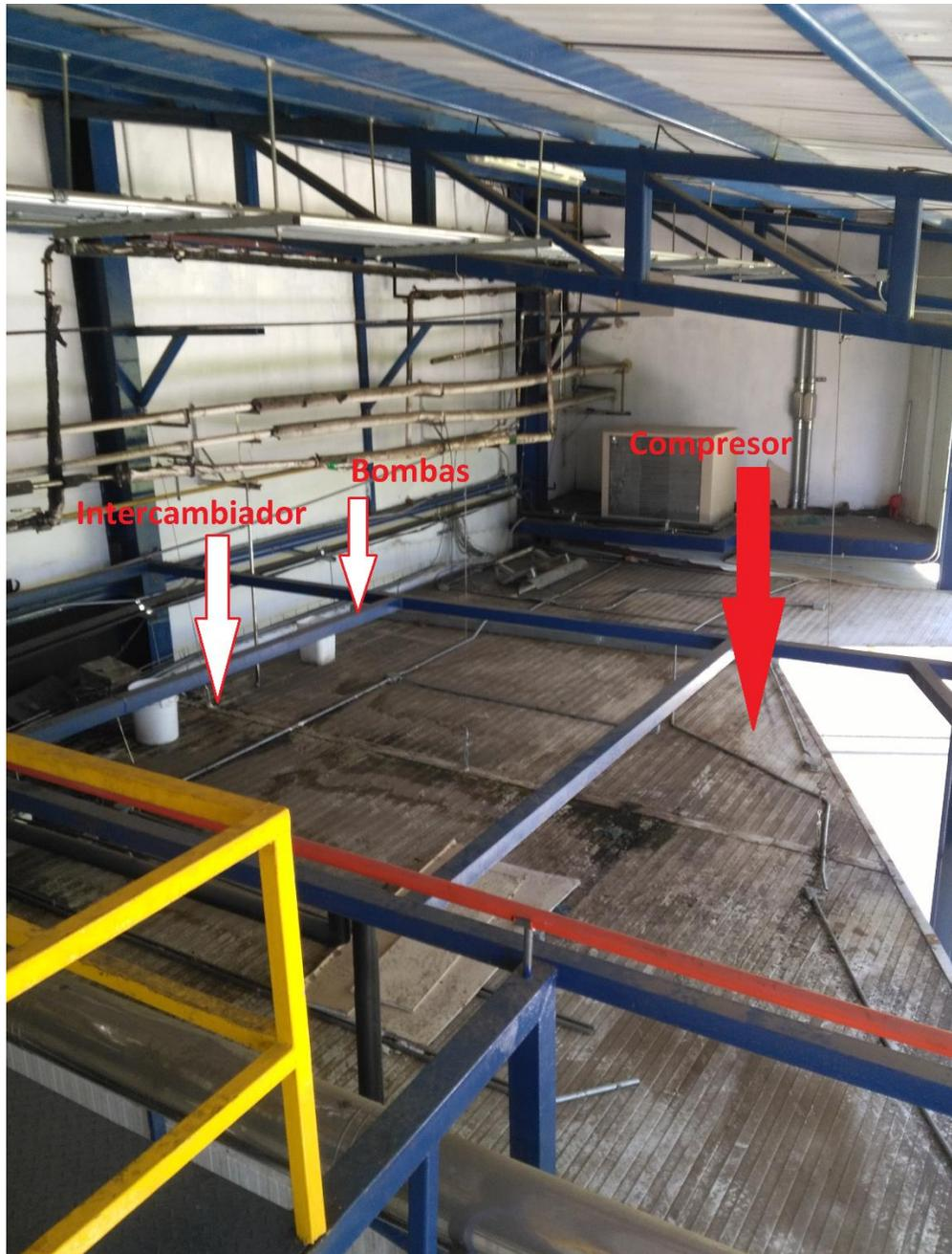
**Figura 27.** Ubicación de los equipos en el cuarto de máquinas
