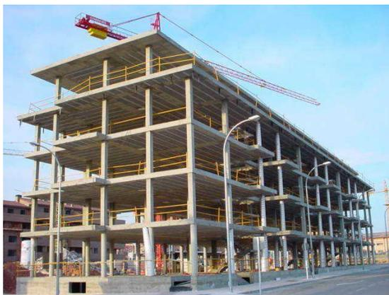
Figura 4.9.1. Marco de concreto (Asociación de fabricantes de morteros y SATE, 2016)
