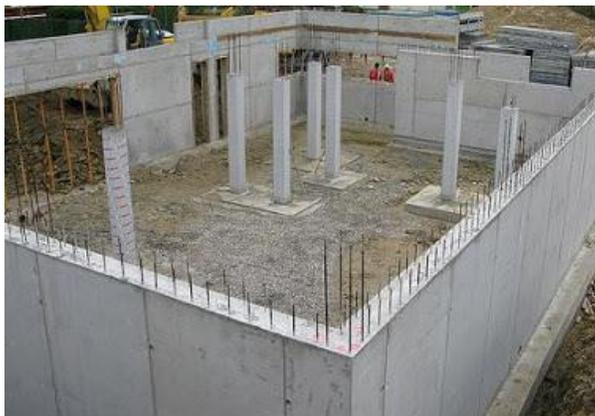
Figura 4.9.2. Construcción en muros de concreto (Morales, 2016)
