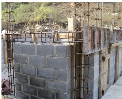
Figura 4.9.5. Muro de mampostería reforzada (M&M Construcciones, 2017)
