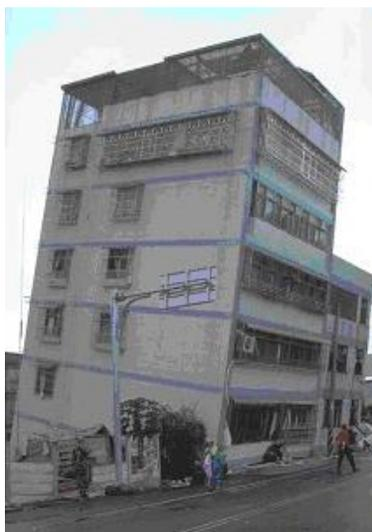
**Figura 6.1.5.** Falla torsional y consecuente inclinación de edificio en Taiwán, 1999 (Taiwan Collection, 2000 citado por Hernández, 2007)
