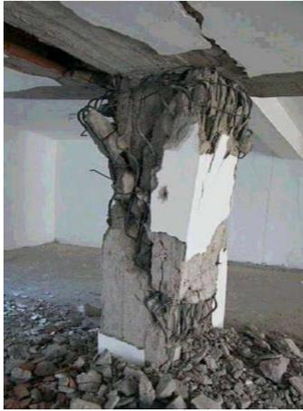
**Figura 2.** Falla a flexocompresión
