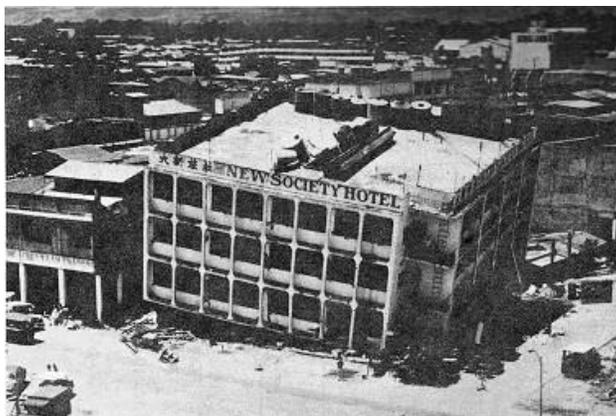
**Figura 6.1.4.** Colapso del primer piso del Hotel New Society, Cotabato City, Mindanao, Filipinas, 1976 (Selna y Tso, 1980 citado por Hernández, 2007)
