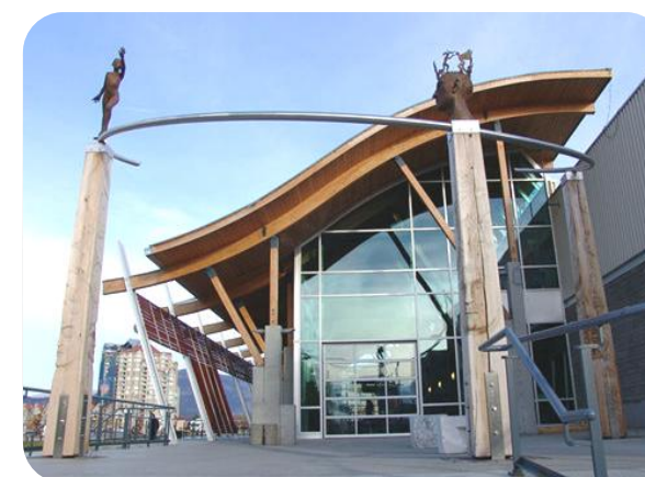
Imagen 13 Vestíbulo exterior Fuente: internet
