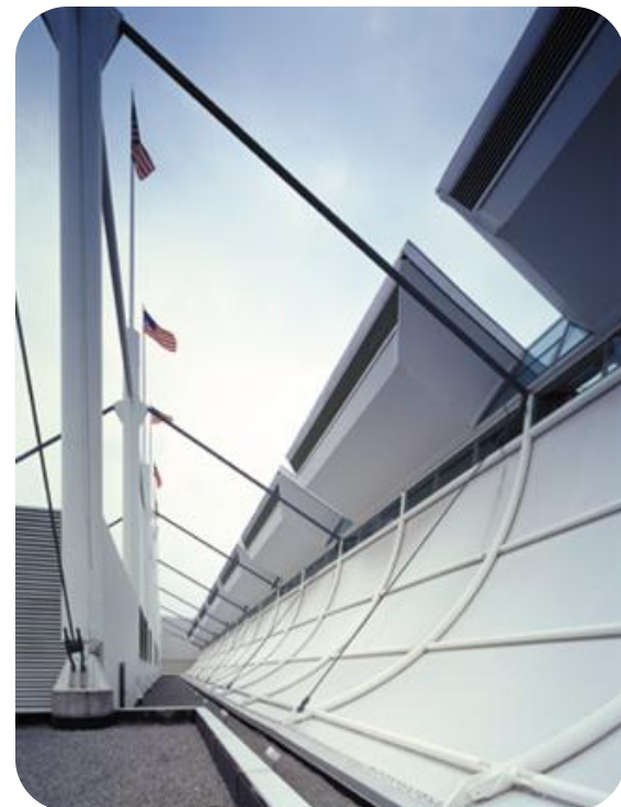
Imagen 21 Vista de tensores en cubierta Fuente: Internet
