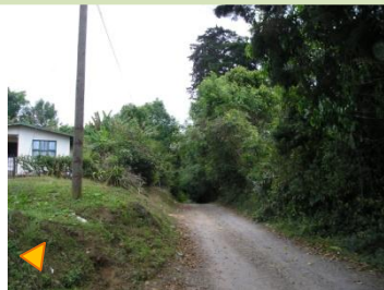
Fotografía 1 Acceso vía principal Fuente: Propia
