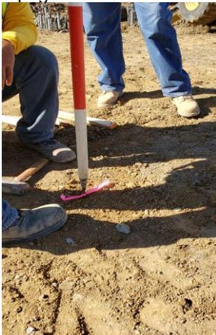
Figura 7. Colocación de las marcas para perforación con equipo de topografía. Fuente: El autor,2019.
