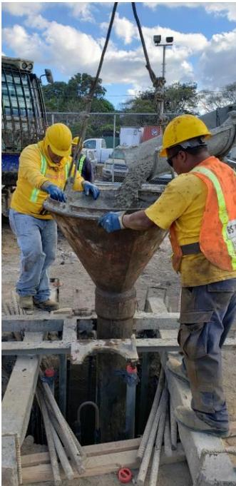
Figura 10. Colocación del concreto con chompipa y tubería. Fuente: El autor 2019.
