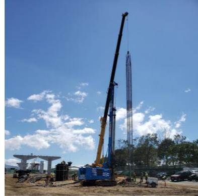
Figura 9. Colocación de la armadura de acero con uso de grúa Tadano ATF60-03. Fuente: El autor, 2019.
