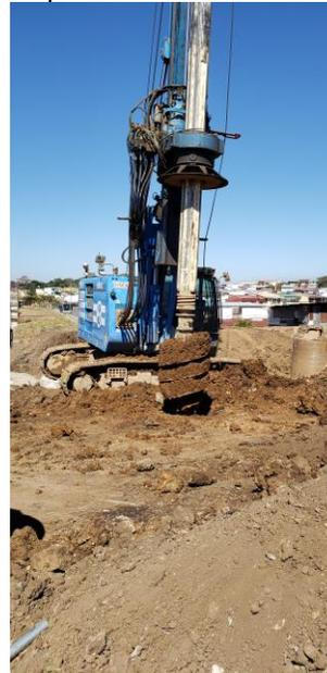
Figura 8. Perforación con perforadora Soilmec SR-45. Fuente: El autor,2019.
