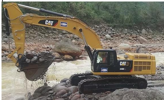
Figura 4. Excavadora 349D 2L marca Caterpillar Fuente. Fotografía tomada el 01/03/2019
