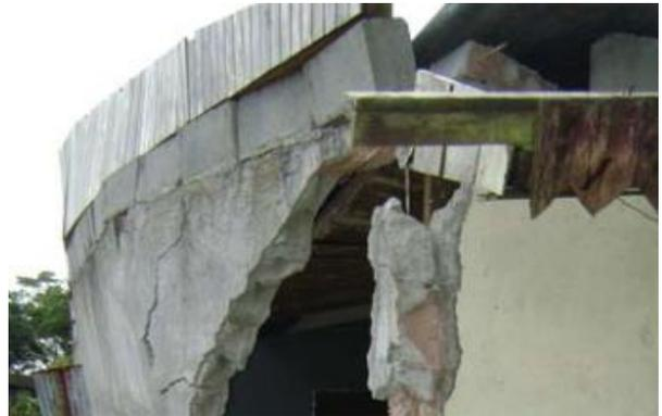
Figura 2. Ausencia de acero horizontal.
