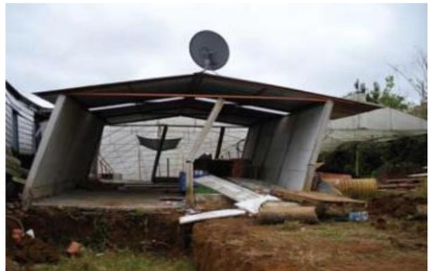
Figura 3. Desplazamiento lateral.
