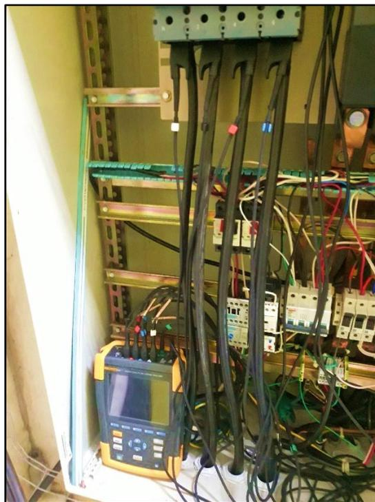
**Figura 5.3.** Conexión del analizador de energía.
