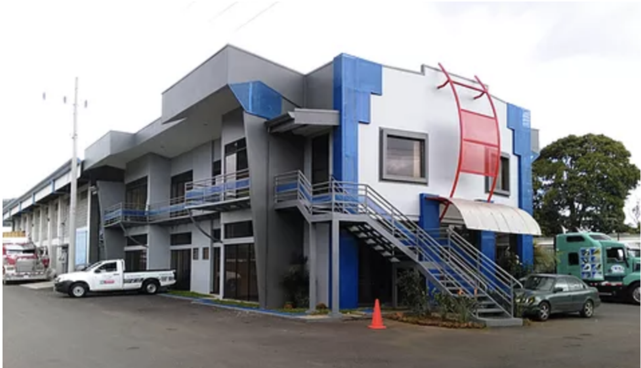
Figura 1: Instalaciones de la empresa en Curridabat. Fuente: Elaboración propia
