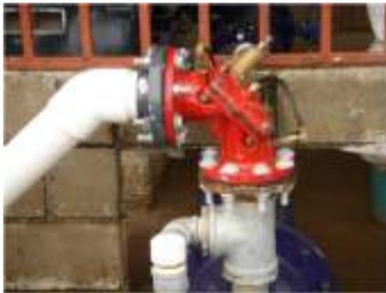
Figura 5.3.2.5.1. Válvula de alivio de presión
