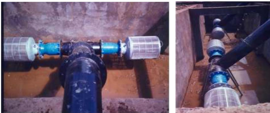
Figura 5.3.3.2. Filtros auto-limpiantes para succión de bombas
