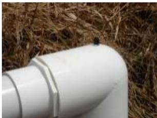
Figura 5.3.2.1.5. Válvula tipo “Schrader” para toma de presión
