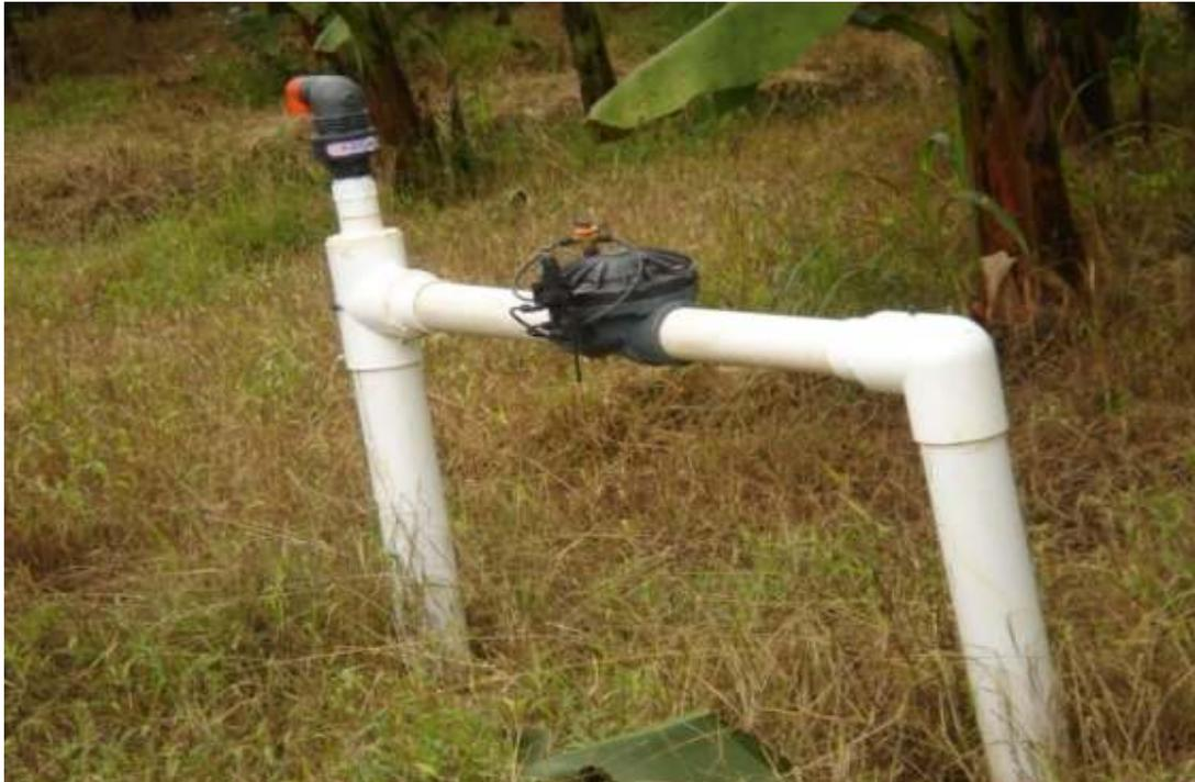
Figura 5.3.2.1.6. Estructura de colocación de válvula hidráulica y purga de aire
