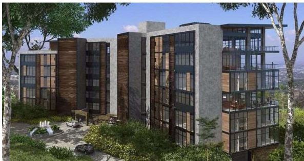
Figura 4. Proyecto Solaris, Torre Fuego, Santa Ana.
