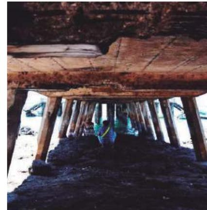
Figura 45. Deterioro estructura del muelle.
