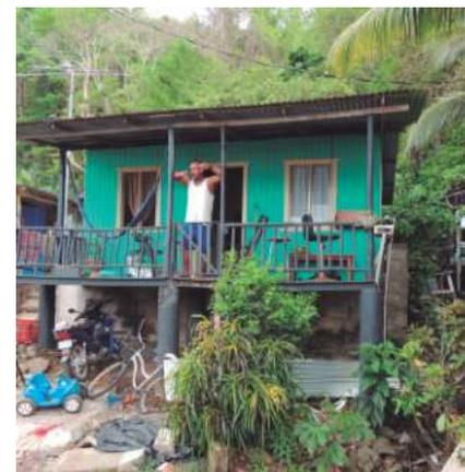
Figura 49. Construcción en pilotes.
