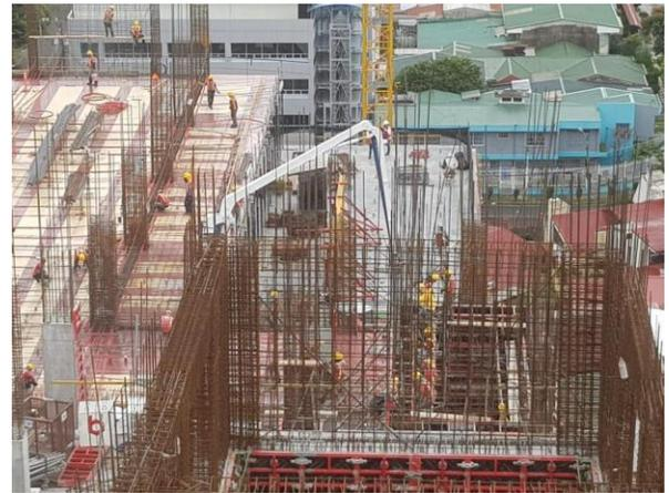
**Apéndice D.** Colado de elementos verticales con colocador de concreto.
