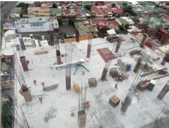
**Apéndice C.** Ubicación del colocador de concreto para colar elementos verticales.
