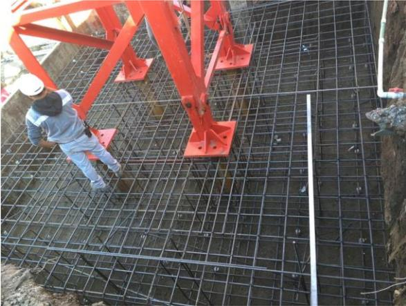
Figura 23 Placa de fundación para grúa Potain MC-205.
