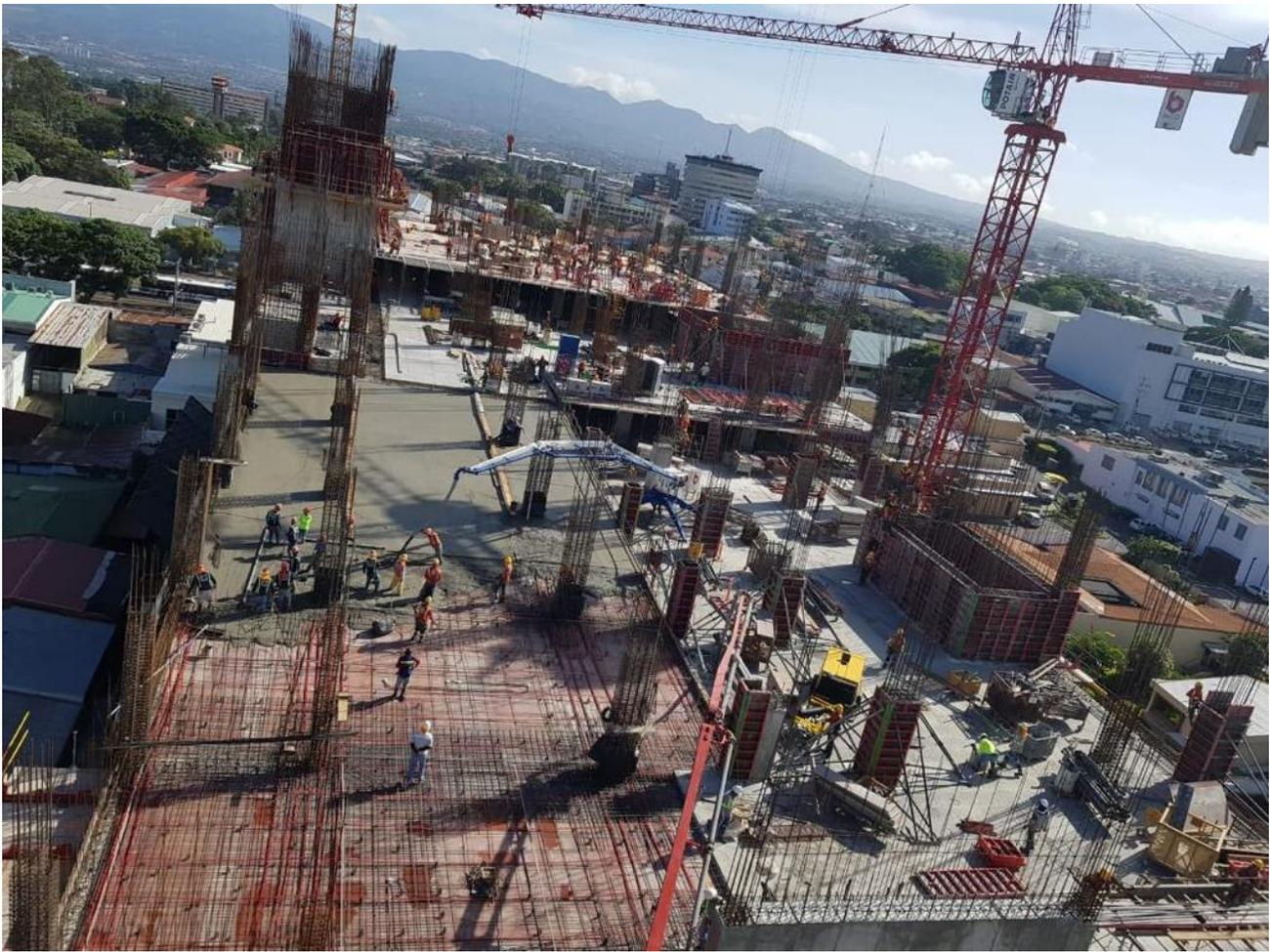
**Apéndice E.** Colado de elementos horizontales con colocador de concreto y movimientos de formaleta vertical con grúa torre.
