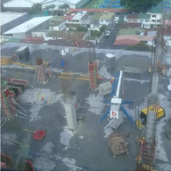
**Apéndice J.** Colocador de concreto ubicado para colar elementos verticales.
