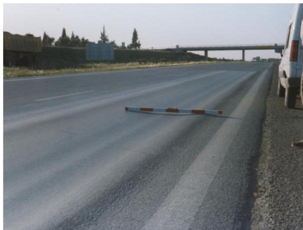
**Figura 18.** Deterioro por roderas o ahuellamientos en pavimentos flexibles y semi-rígidos.
