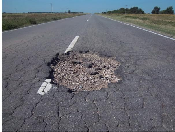
**Figura 17.** Deterioro por baches en pavimentos flexibles y semi-rígidos.
