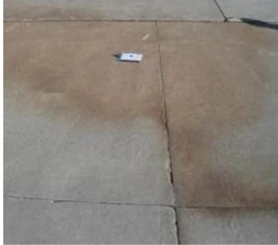
**Figura 26.** Deterioro por bombeo de finos en pavimentos rígidos.
