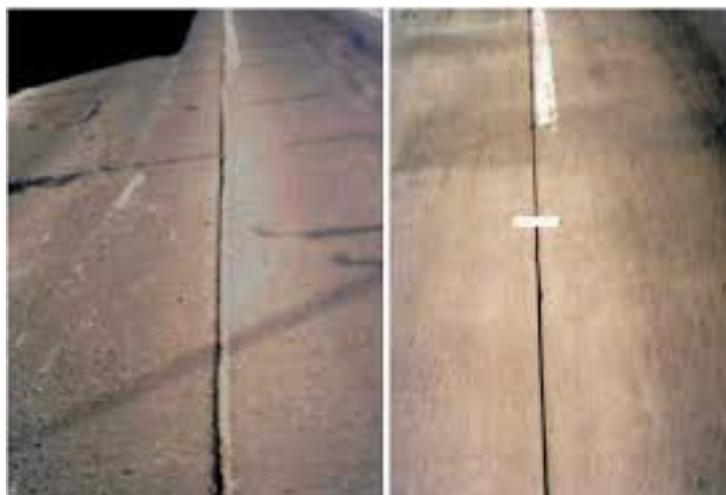
**Figura 25.** Deterioro por separación de losas en pavimentos rígidos.
