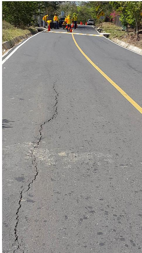
**Figura 15.** Deterioro por agrietamiento longitudinal en pavimentos flexibles y semi-rígidos.
