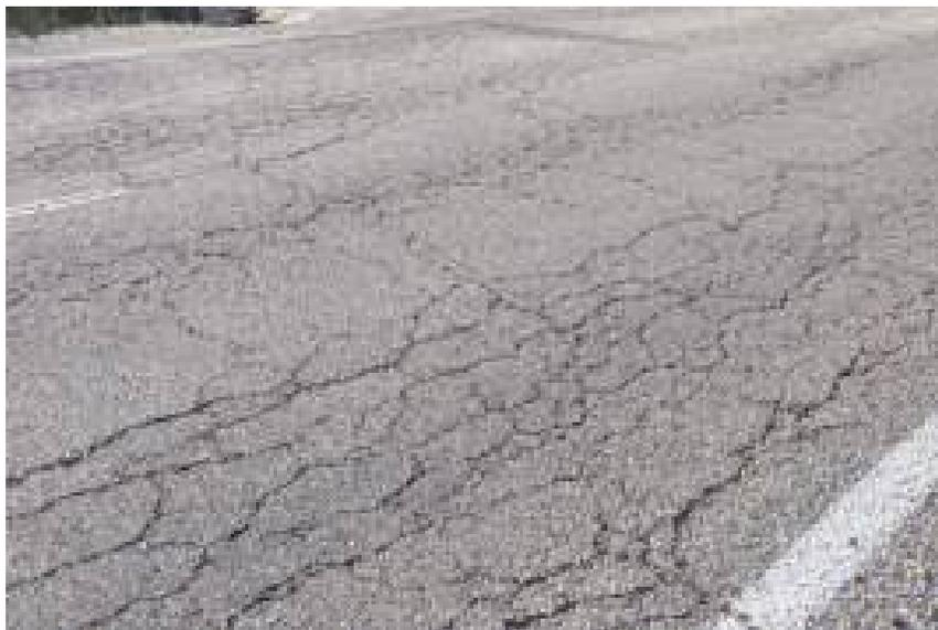
**Figura 14.** Deterioro por agrietamiento cuero de lagarto en pavimentos flexibles y semi-rígidos.
