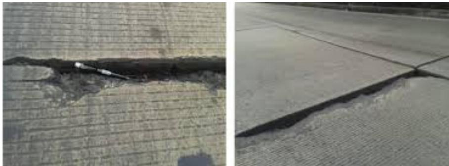
**Figura 23.** Deterioro por pérdida de sello en las juntas de las losas en pavimentos rígidos.
