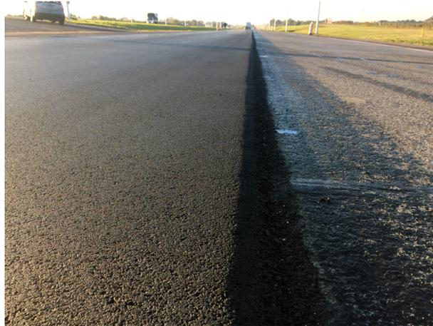
**Figura 19.** Deterioro por exudación en pavimentos flexibles y semi-rígidos.
