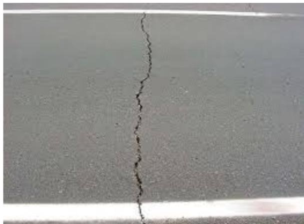
**Figura 16.** Deterioro por agrietamiento transversal en pavimentos flexibles y semi-rígidos.
