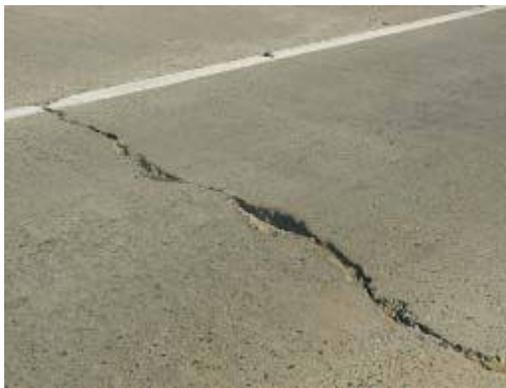
**Figura 21.** Deterioro por agrietamiento transversal en pavimentos rígidos.
