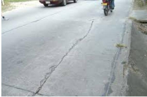
**Figura 20.** Deterioro por agrietamiento longitudinal en pavimentos rígidos.
