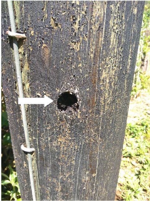
Figura 80. Agujeros sobre la superficie del poste.
