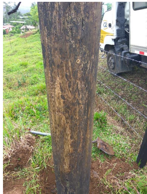
Figura 86. Desprendimiento del preservante superficial, visualización del color natural de la madera.
