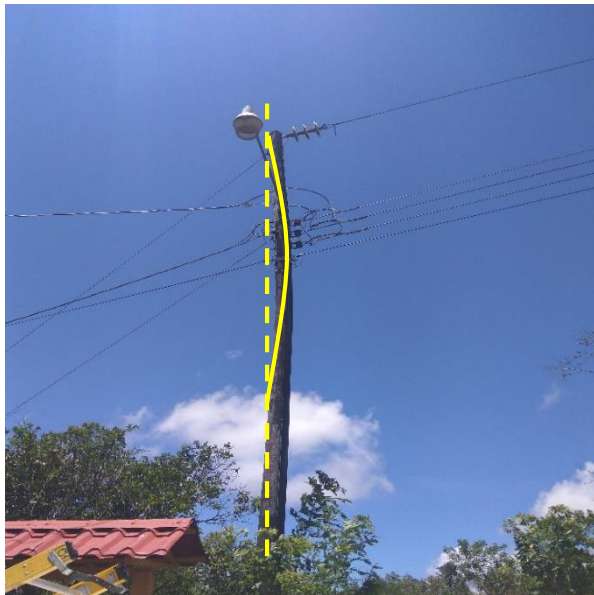
Figura 88. Deformaciones por tensión de los conductores.
