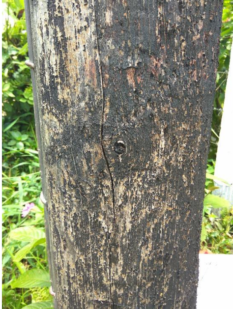
Figura 87. Desprendimiento del preservante superficial.
