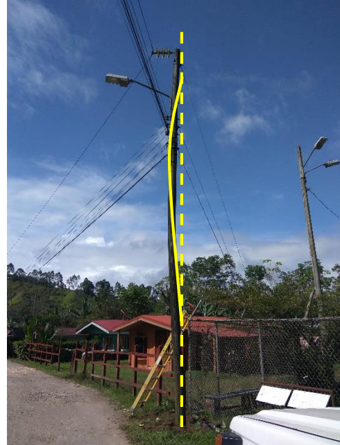
Figura 89. Deformación por tensión de los conductores.
