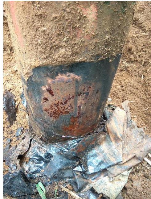
Figura 78. Presencia de hongos y pudrición a nivel de distancia desenterrada.
