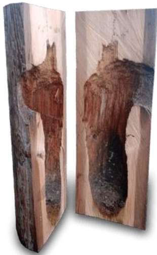
Figura 14. Pérdida de sección por pájaro carpintero. Fuente. Toppng, 2019.
