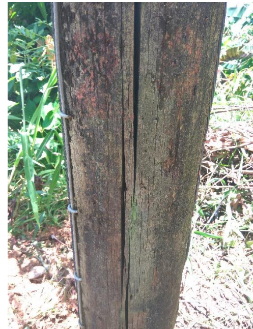
Figura 82. Formación de grietas.
