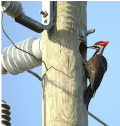
Figura 13. Ejemplo de agujeros de pájaro carpintero en poste de madera. Fuente. Osmose, (s.f.).
