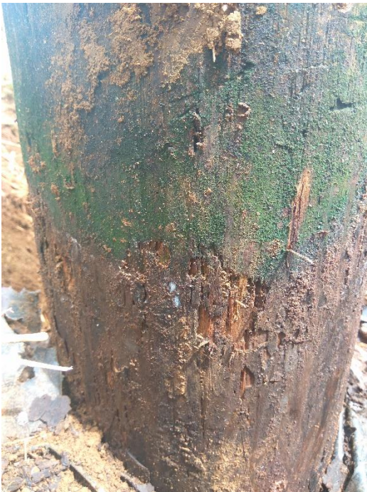
Figura 76. Deterioro a nivel de línea de suelo con pérdida de sección, inicio de pudrición.
