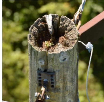
Figura 15. Ejemplo de degradación de la cúspide de poste de madera. Fuente. RTO Insider, 2019.
