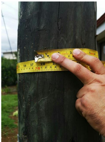
Figura 27. Medición de la circunferencia del poste de madera.
