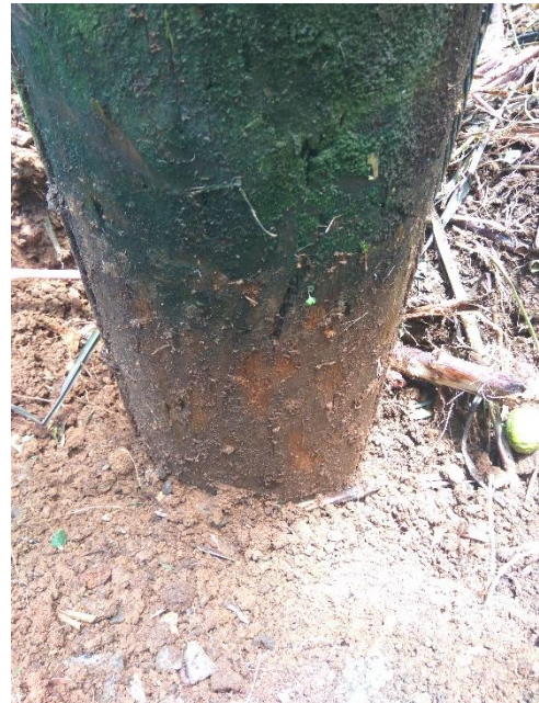
Figura 74. Formación de líquenes sobre la superficie desenterrada.
