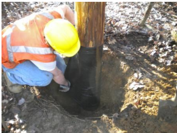
Figura 71. Tratamiento a nivel del suelo en poste de madera.
