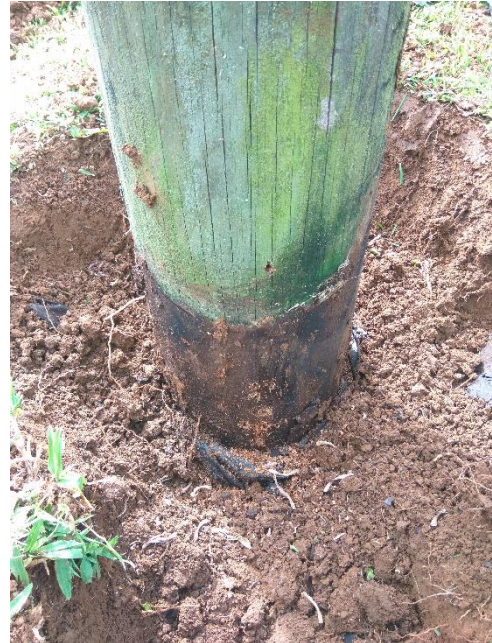
Figura 73. Inspección de 30 cm enterrados, con evidencia de tratamiento posterior a la instalación.
