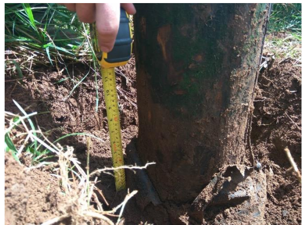
Figura 17. Desentierro de 30 cm por debajo de la línea del nivel del suelo.
