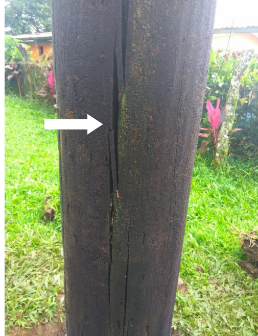
Figura 81. Formación de grietas anchas y profundas.
