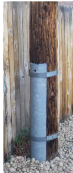
Figura 70. Restauración de acero para poste de madera. Fuente. Osmose, (s.f.).
