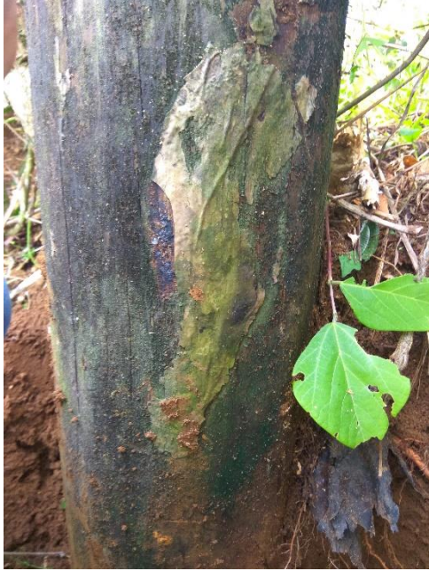
Figura 79. Evidencia de pudrición sobre la línea de suelo.
