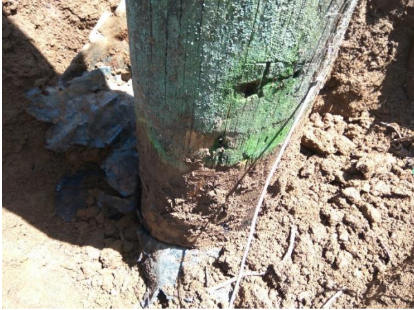
Figura 75. Evidencia de deterioro a nivel de la línea desenterrada, pérdida de sección y hundiciones.
