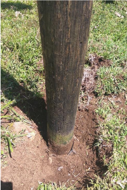
Figura 72. Desentierro de poste a nivel de línea de tierra conservado, con mínima presencia de humedad.
