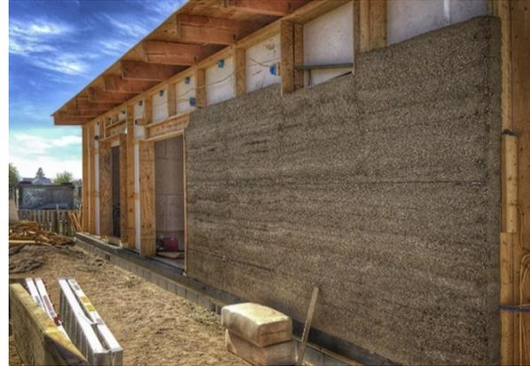
**Figura 5:** Casa de concreto con sustitución del cemento por fibras de cáñamo. (Fuente: Obras por Expansión (2017).)
