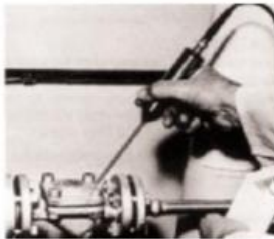
Figura 3.8. Estetoscopio para revisión de trampas de vapor
