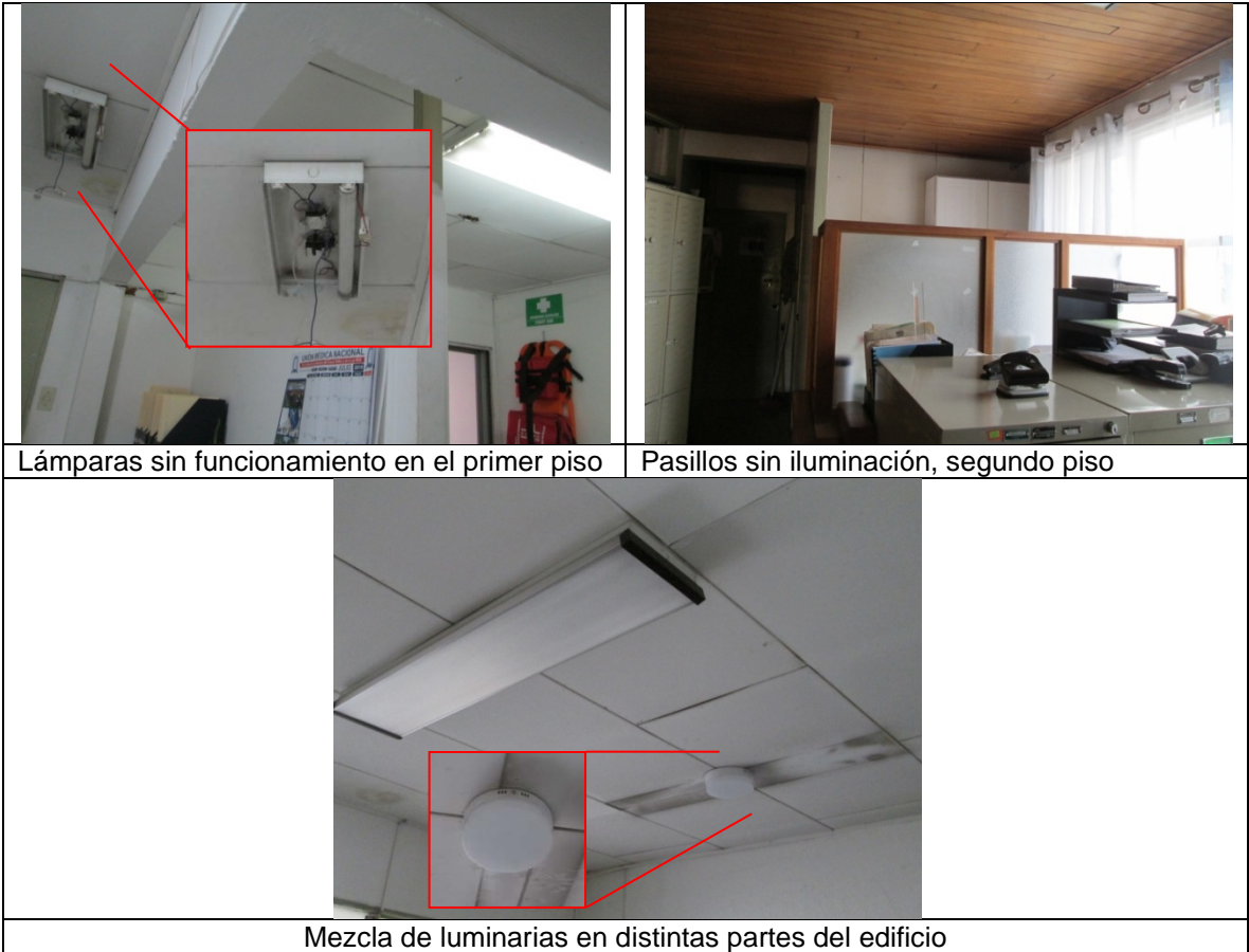
Figura 7. Condiciones de las luminarias del plantel
