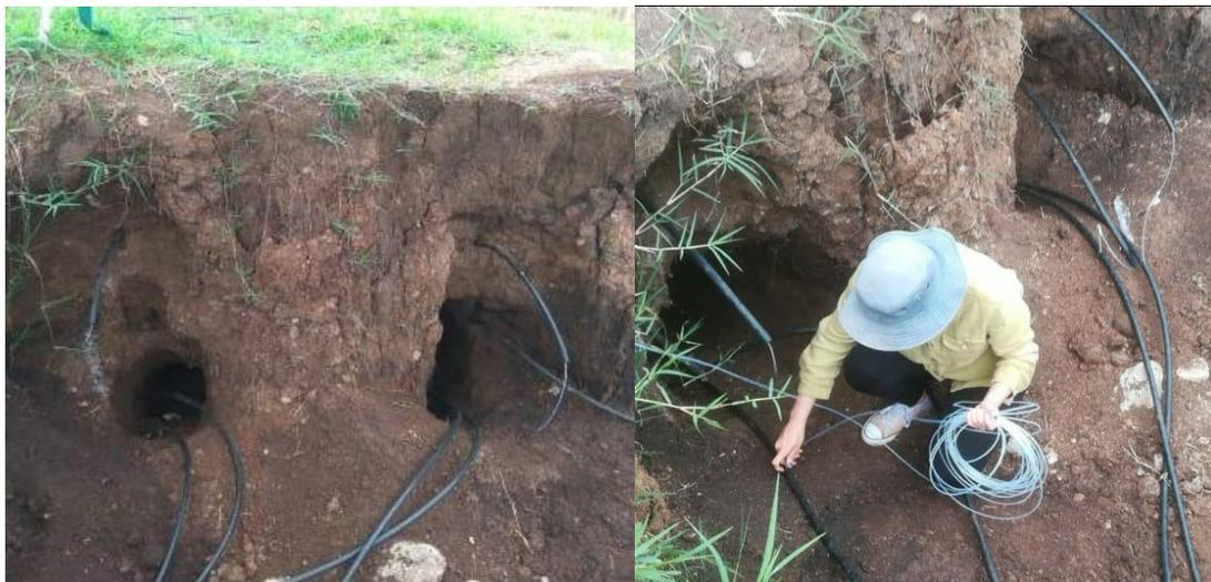
*Figura 12. Instalación de sensores de muestreo y línea de conducción a estación de monitoreo (Lisímetros de succión y reflectómetros)*
