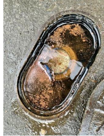
**Figura 30.** Evidencia de hidrómetro cubierto por agua llovida y manchado por sedimento. Fuente: fotografía propia.
