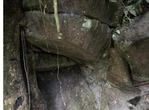
**Figura 14.** Desprendimiento de rocas sobre el tanque de captación de Higueros #2. Fuente: fotografía propia.
