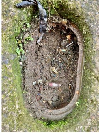
**Figura 27.** Evidencia de hidrómetro cubierto por sedimentos.
