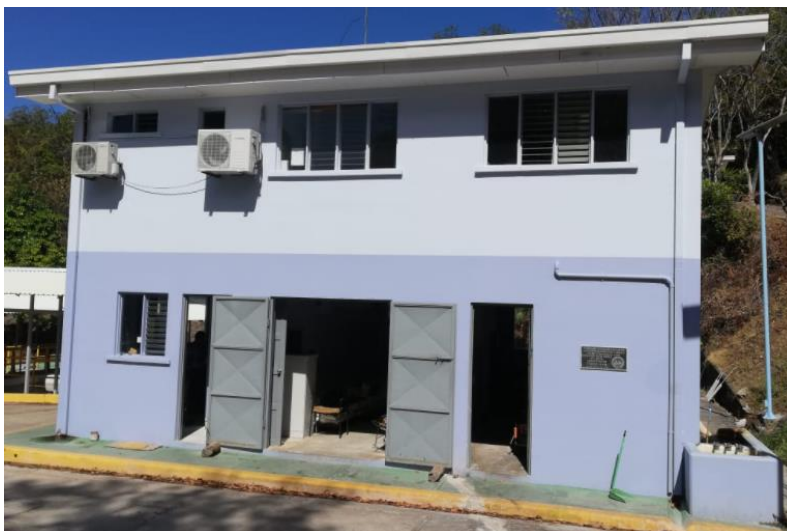
Figura 4-6. Planta sulfatadora de agua de la Planta Potabilizadora de Liberia.
