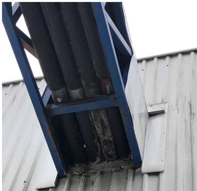
**Figura A.5.1; Material aislante tubería de conducción externa cubierto de hielo entre las cámaras de refrigeración y el cuarto con los equipos de refrigeración, sucursal Dos Pinos Coronado.**
