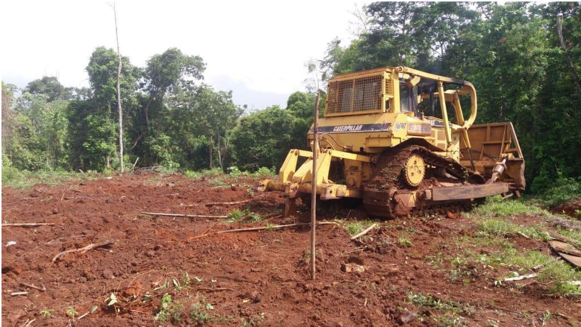
Figura 2. Maquinaria utilizada para la realización del ensayo.
