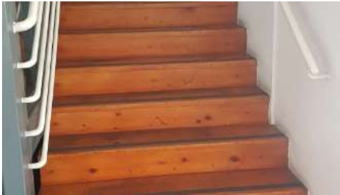
Escaleras interiores SJ-02
