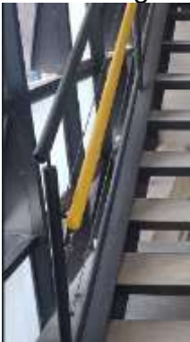
Escaleras de emergencia SJ-06
