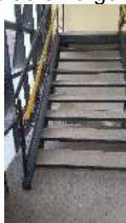
Escaleras de emergencia SJ-06
