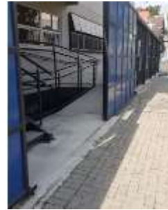
Rampa de ingreso al edificio SJ-06 desde la acera
