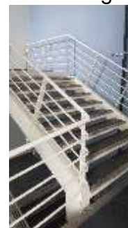
Escaleras de emergencia SJ-02
