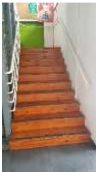
Escaleras interiores SJ-02
