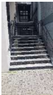
Escaleras de acceso SJ-06
