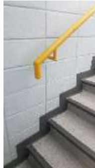
Escaleras interiores Sj-01
