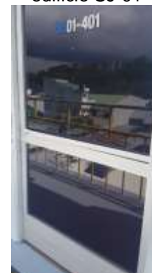
Puertas hacia el balcón en edificio SJ-01
