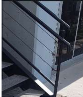
Escaleras de acceso SJ-06
