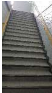
Escaleras interiores Sj-01
