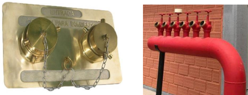
Figura 42. Siamesa y múltiple de pruebas para Bomberos
