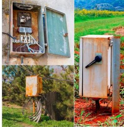
**Figure 1.2.** Ejemplos de gabinetes expuestos al aire libre en estado de corrosión por factores ambientales (Fuentes,2020).
