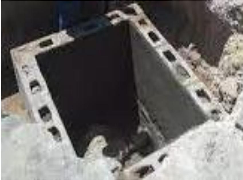
*Figura 35. Fosa de protección de la válvula de aire y limpieza*
