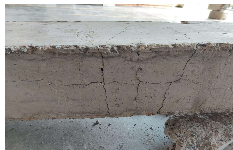
Figura 74. Agrietamiento longitudinal presentado en la cara inferior de las vigas híbridas
