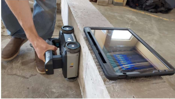
Figura 49. Proceso de escaneo de la viga de concreto.
