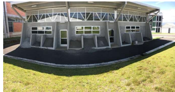
Figura 16. Silos de almacenamiento de los agregados.
