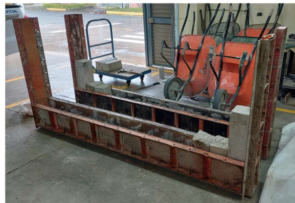
Figura 37. Formaleta armada y lista para ser utilizada.
