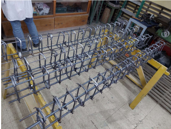
Figura 35. Construcción de las armaduras de vigas.
