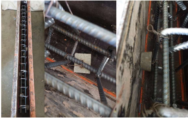
Figura 38. Armadura de acero posicionada en el encofrado.
