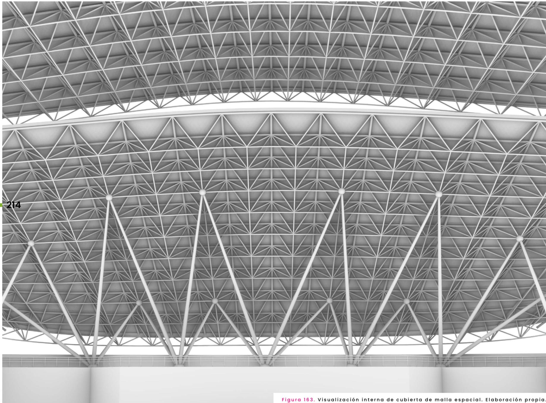
Figura 163. Visualización interna de cubierta de malla espacial. Elaboración propia.
