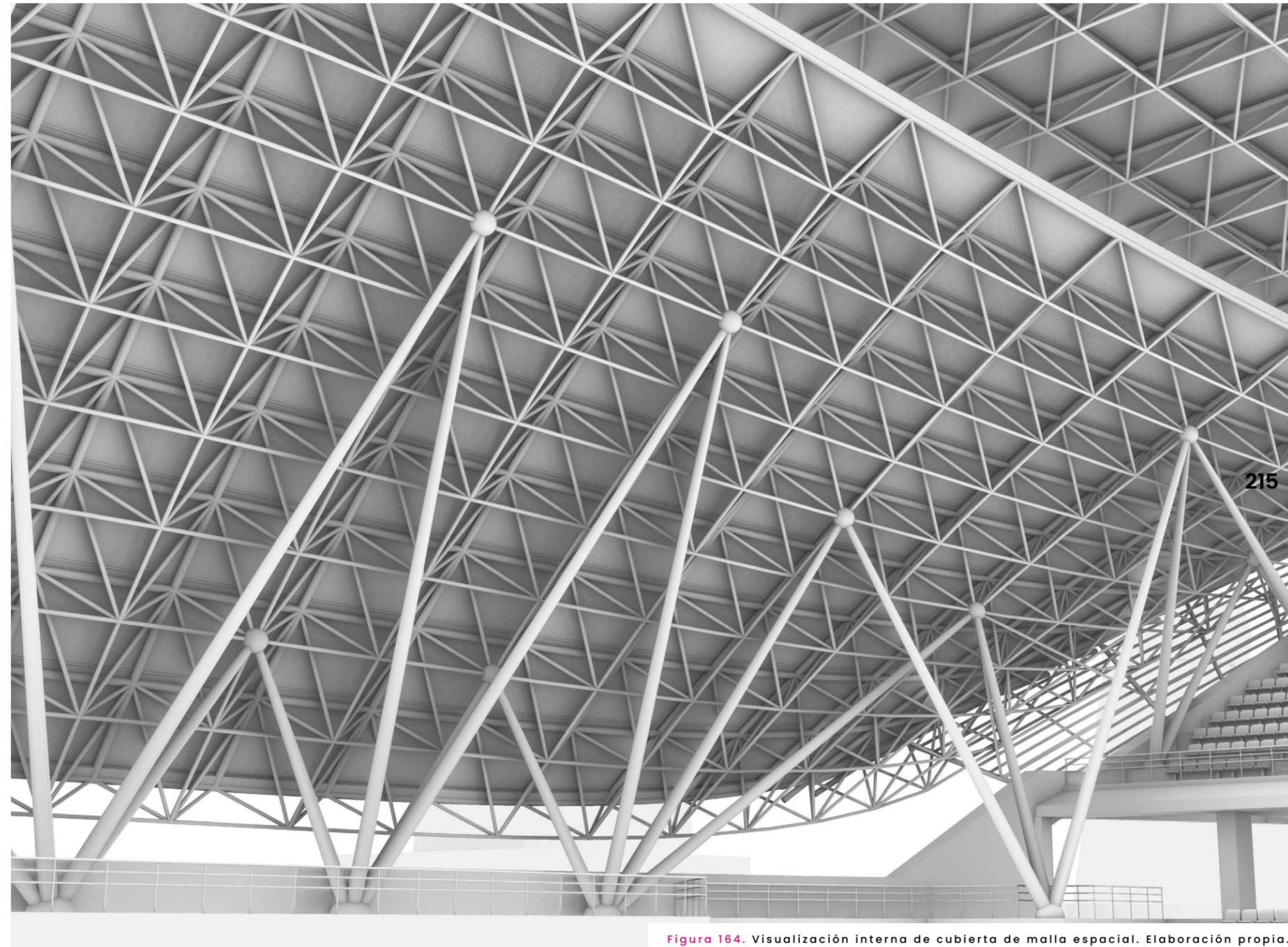
Figura 164. Visualización interna de cubierta de malla espacial. Elaboración propia.
